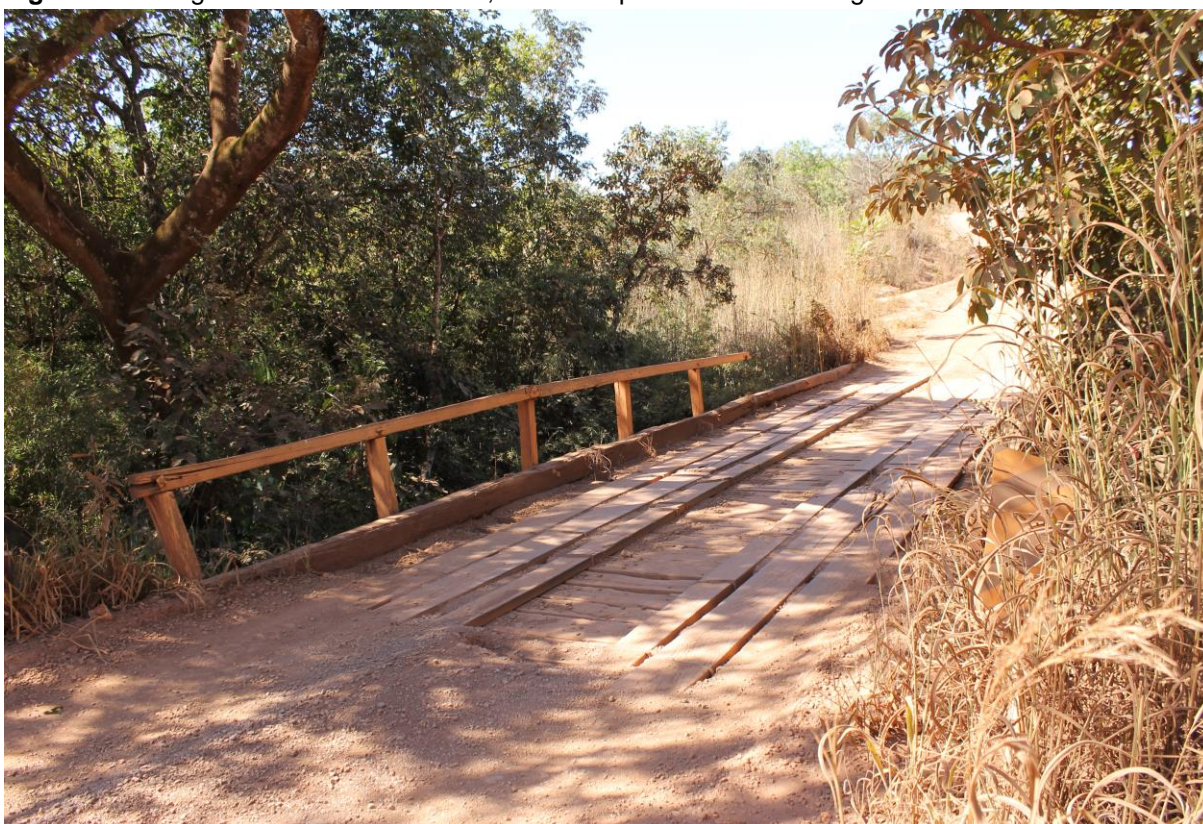
Figura 4 – Fotografia da estrada DF-205, km 59 na ponte sobre o córrego Vereda Grande.
