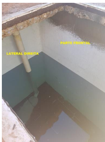
Figura 20 – Lateral direita do reservatório
