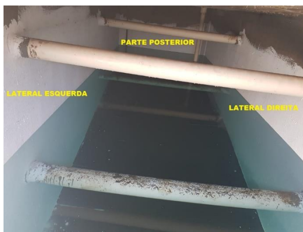
Figura 21 – Lateral direita do reservatório
