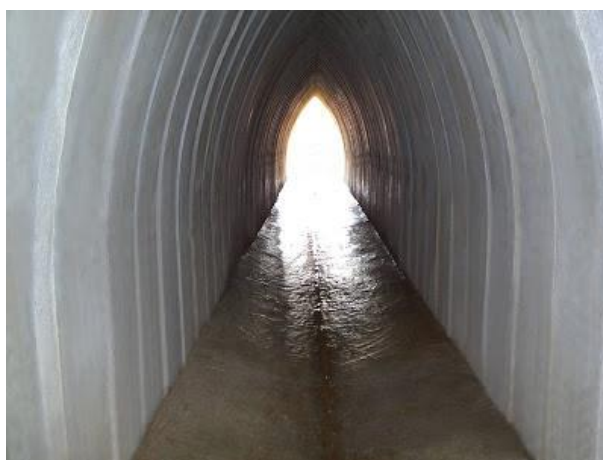
Figura 4 – Túnel bala com passagem fluvial
