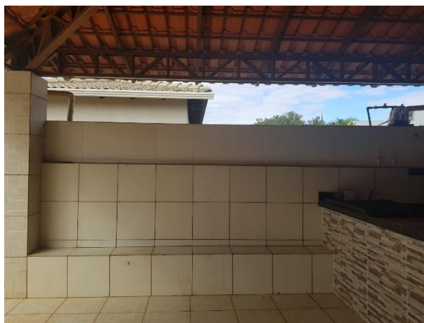
Figura 17 – Lateral direita do reservatório
