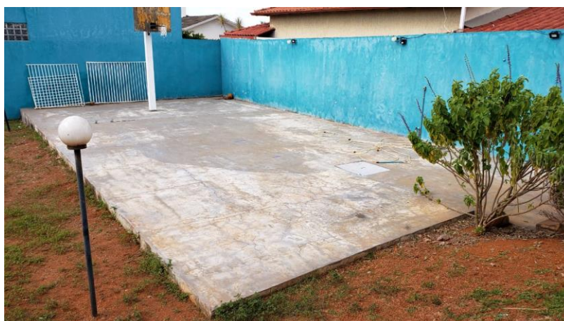
Figura 30 – Piscina após da execução da laje
