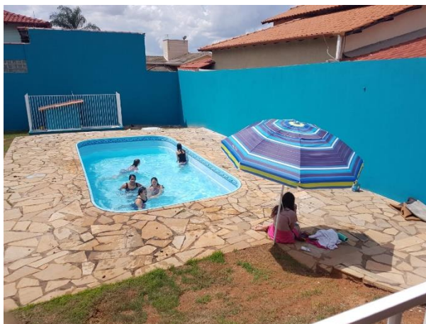
Figura 29 – Piscina antes da execução da laje
