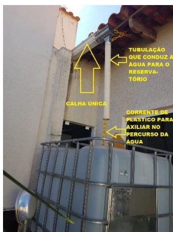
Figura 26 – Detalhes do reservatório
