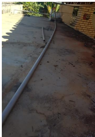
Figura 19 – Laje do reservatório
