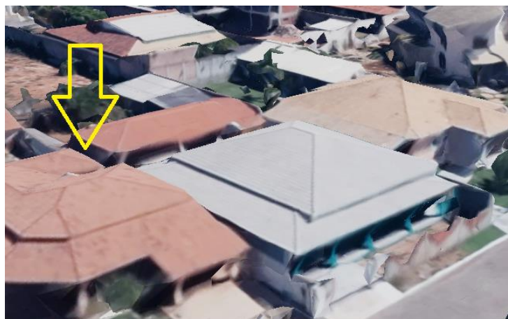
Figura 14 – Localização do reservatório
