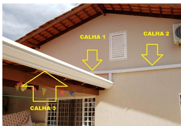
Figura 34 – Localização das calhas, parte posterior da residência
