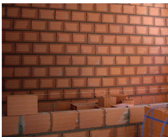
Figura 12 – Parede de alvenaria
