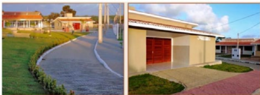
Figura 12 – Pista de caminhada e Centro de Saúde do Condomínio Cidade Madura
