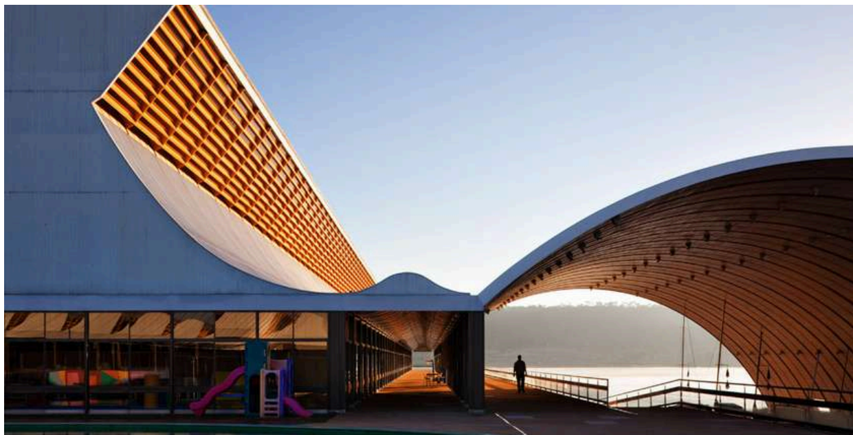
Hospital Sarah - Lago Norte, Brasília - DF projetado por João Filgueiras Lima. Fonte: www.archdaily.com.br acesso 31/03/2026.
