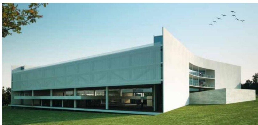
Figura 6 - Vista da fachada principal da Nova Sede Sebrae Nacional.
