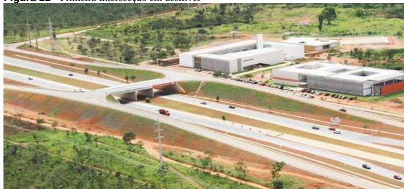
Figura 11 - Primeira Intersecção em desnível
