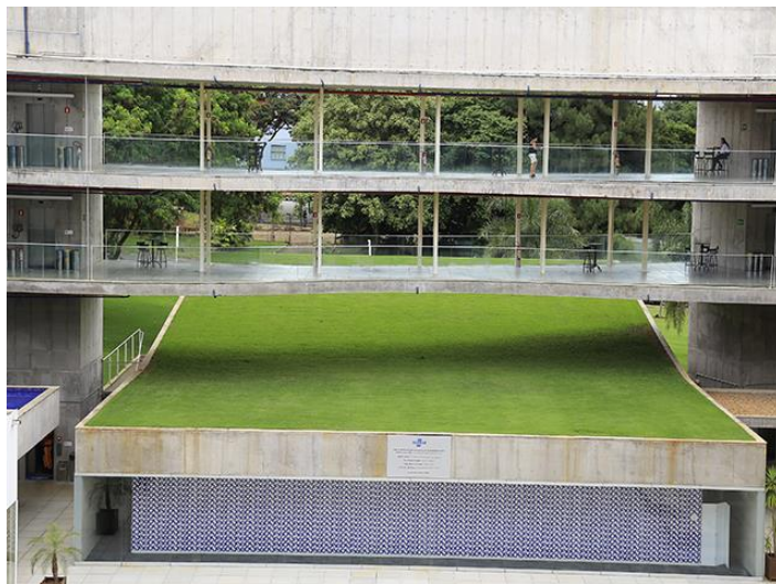
Figura 7: Iluminação natural, telhado verde e painel Galvão.
