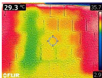
Figura 24. Medição oposta azulejo de 6mm.
