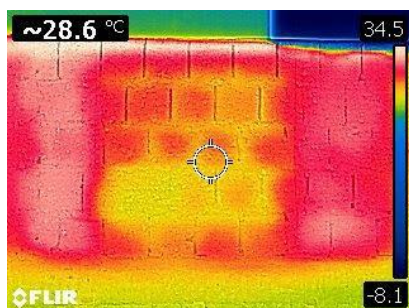
Figura 5. Medição oposta azulejo de 3mm.
