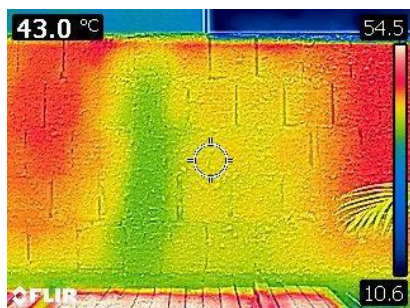
Figura 30. Medição oposta azulejo de 6mm.
