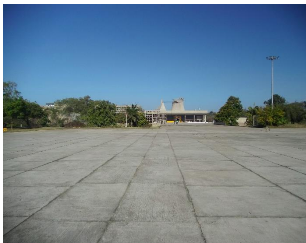
Figura 3 - Capitólio de Chandigarh.
