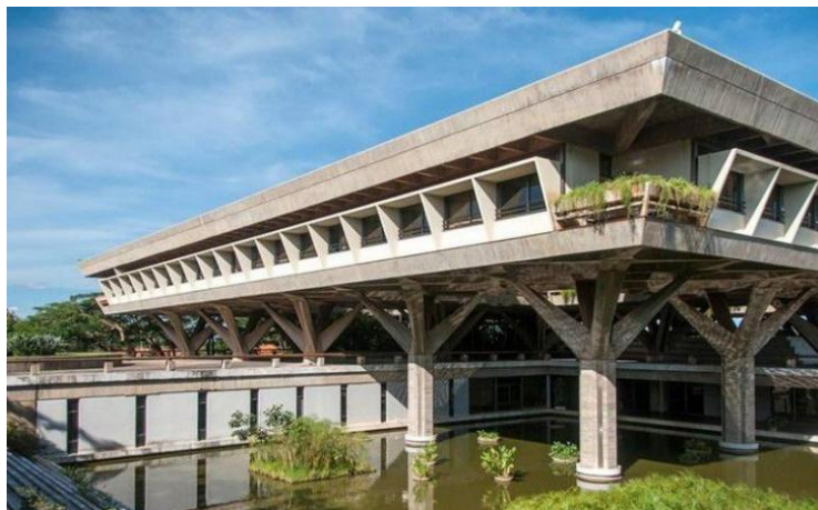
Figura 3: Vista dos pilares octogonais.
