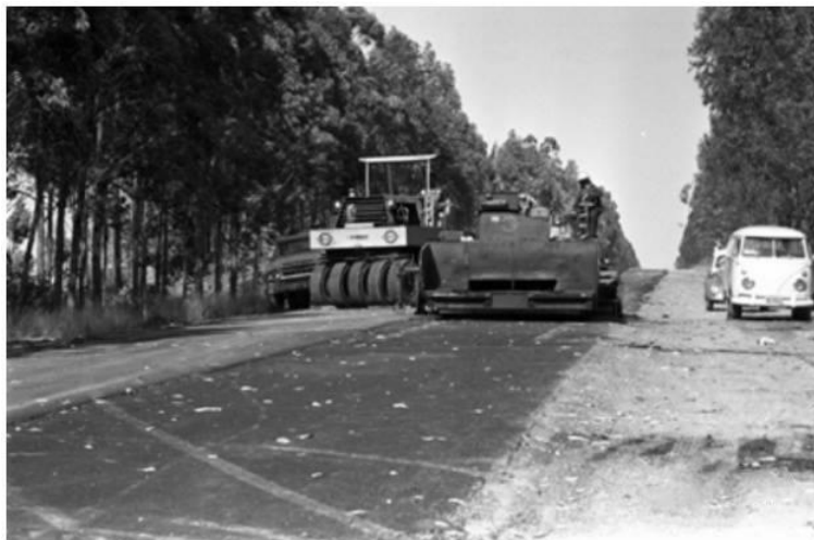
Figura 01 - Estrada da saída do Gama sendo asfaltada.
