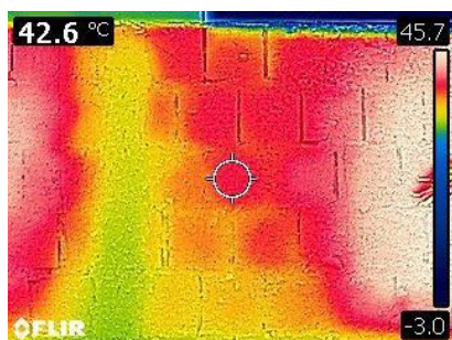
Figura 12. Medição oposta azulejo de 6mm.
