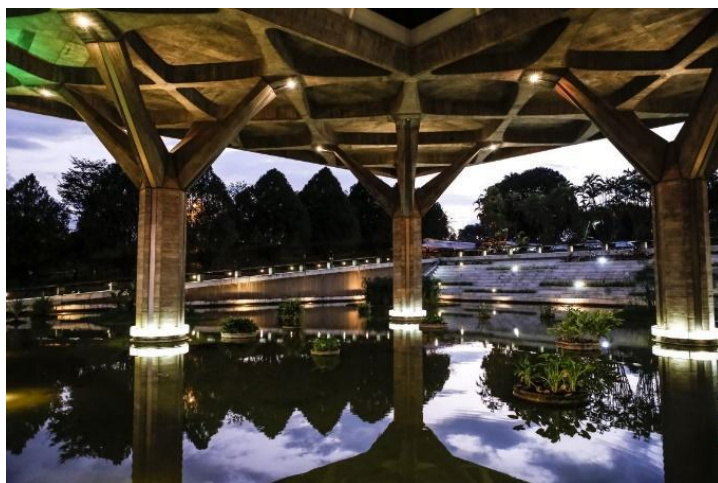
Figura 2: Vista dos pilares octogonais.
