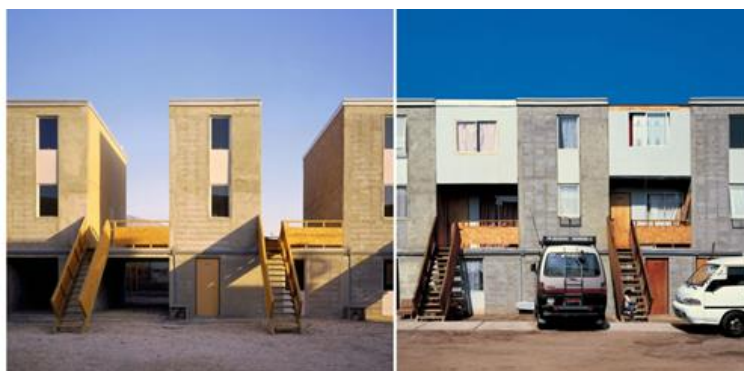
FIGURAS 8 e 9: Composição arquitetônica original e após 12 anos de ocupação.
