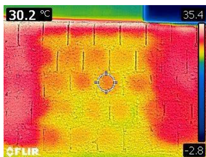
Figura 23. Medição oposta azulejo de 3mm.
