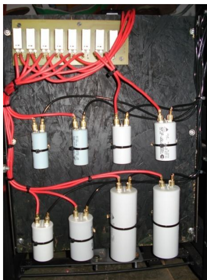
Figura 4.18-Montagem final do banco de capacitores
