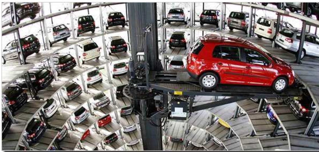
Figura 2.1 - Estacionamento vertical. (Fonte: METALICA, 2011).
