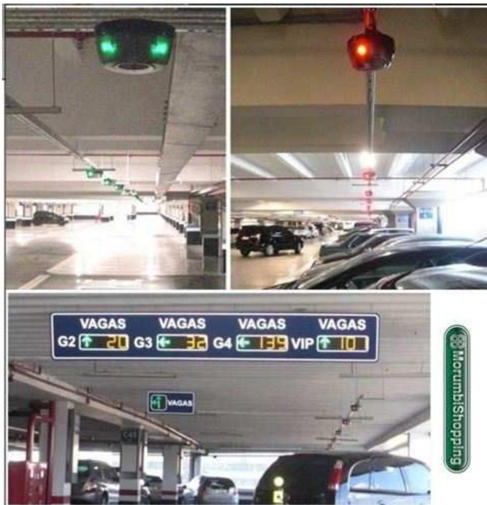
Figura 2.3 – Estacionamento automatizado do Morumbi Shopping.
