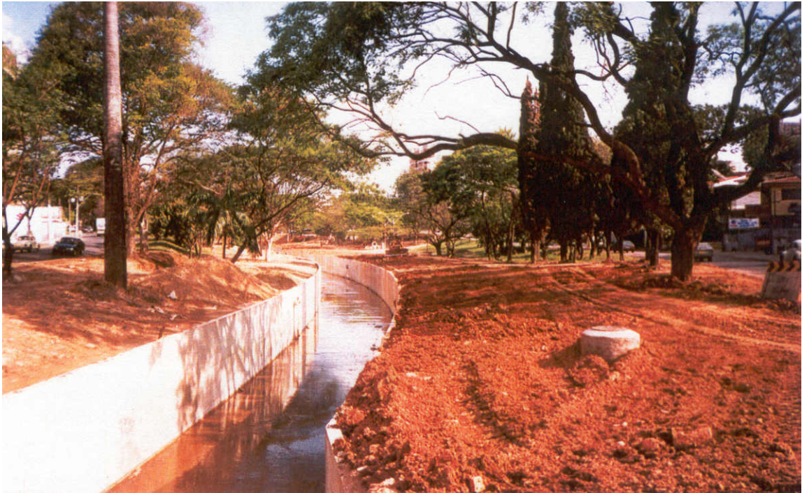
Figura A.5 - Canalização Ribeirão Anhumas (local onde o canal tem seção retangular aberta)
