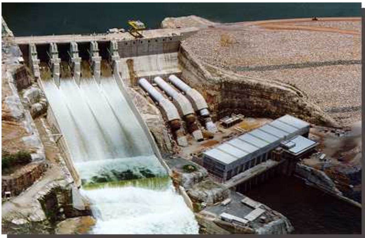
Figura 3- Usina hidrelétrica de Corumbá – FURNAS, 4 geradores num total de 375 MW. Tensão 13,8 kV. (CONTROLLINE, 2008)
