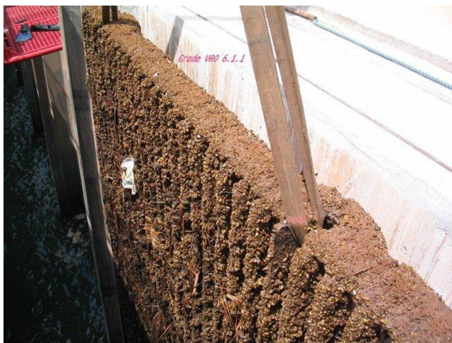
Figura 9 - Equipamento de estação de tratamento de águas totalmente recoberta por colônias de mexilhões dourados
