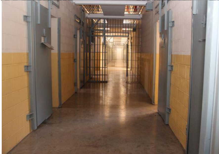
Corredor principal de acesso às celas
