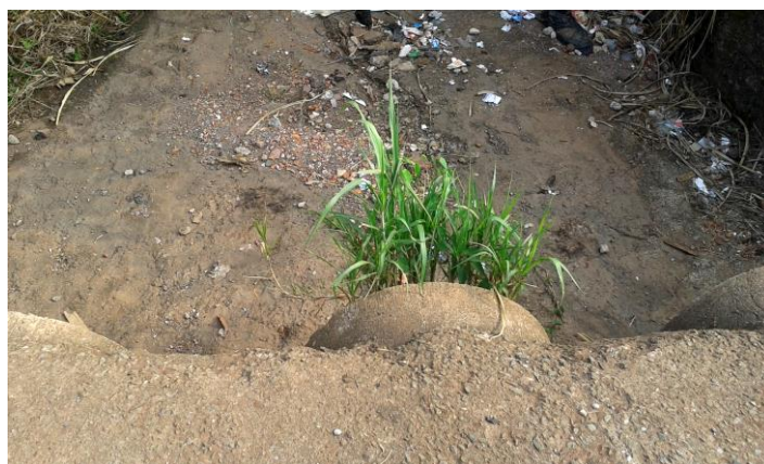
Figura 6: Manilha de águas pluviais. Via de Ligação Qnf/Qnj. Foto da autora
