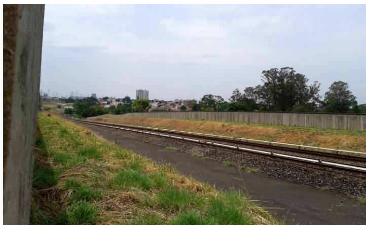
Figura 12: Ferrovia metrô – Samambaia. Foto da autora
