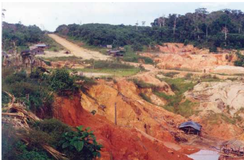
Figura 4 – Aspecto dos processos erosivos no garimpo Bom Jesus.
