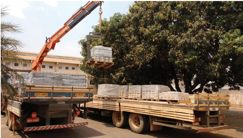
Figura 11: Caminhão Munck Carregado.
