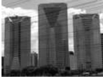
Foto 157A – Centro Empresarial Nações Unidas: fachadas Fonte – Foto da autora, 2006
