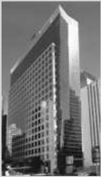
Foto 124 – Edifício Comendador Yerchanik Kissajikian: fachada Fonte – CORBIOLI (2003, p. 58)
