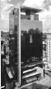
Foto 132 – Edifício Os Bandeirantes: vista aérea Fonte – MOURA (1995, p. 49)
