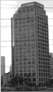
Foto 151 – Centro Administrativo Philips: fachada
