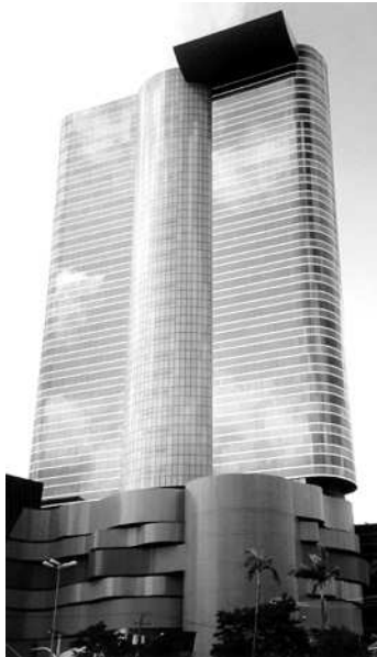
Foto 140 – Complexo Ohtake Cultural: fachada Edifício Faria Lima
