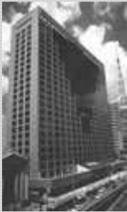
foto 121 – Edifício São Luís Gonzaga: vista aérea Fonte – MEGAEDIFÍCIO (2000, p. 98)
