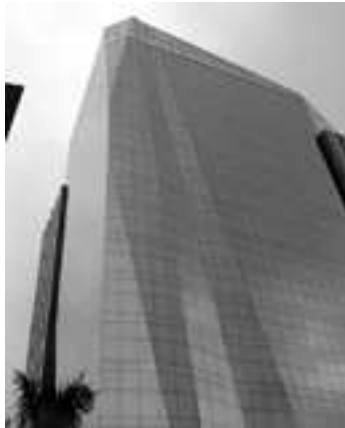
Foto 144 – Edifício Birman 31: detalhe da fachada Fonte – Foto da autora, 2006
