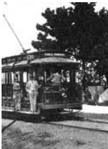
Foto 67 – Bonde elétrico Fonte: CAMPOS (2002, p. 333)
