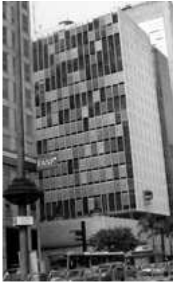
Foto 114 – Edifício Sul-Americano: fachada
