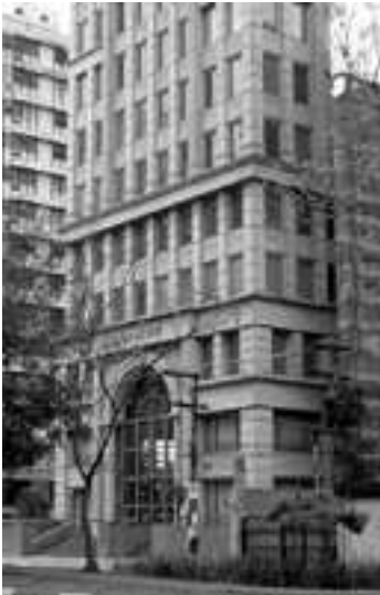
Foto 137 – Edifício San Paolo: detalhes da fachada
