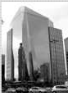
Foto 143 – Edifício Birmann 31: fachada
