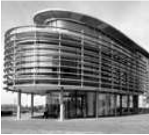
Foto 56 – DVG Headquarters: vista da fachada
