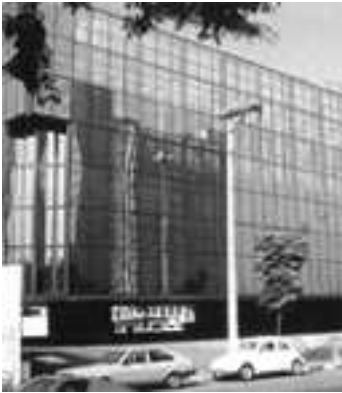
Foto 130 – Edifício Sede da Mineração Itaquí: detalhe da fachada
