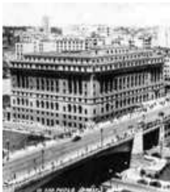
Foto 59 – Viaduto do Chá (1938): projeto de Elisário Bahiana Fonte: Disponível em: http://www.fotosedm.hpg.ig.com.br/postais Acessado: mar. 2006.
