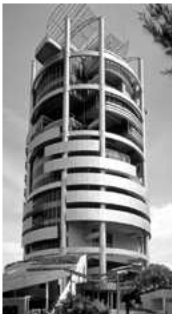
Foto 53 – Edifício Menara Mesiniaga, Sede da IBM: fachada Fonte: Disponível em: www.archnet.org Acessado em: ago. 2006
