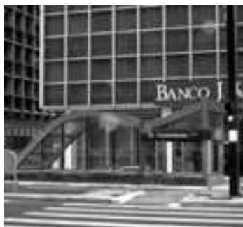
Foto 78 – Avenida Paulista: acesso à estação Consolação do metrô (2006)
