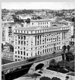
Foto 100 – Edifício Alexandre Mackenzie: 1º fase completa Fonte – Disponível em: http://www.aprenda450anos.com.br/450anos Acessado em : mar. 2006
