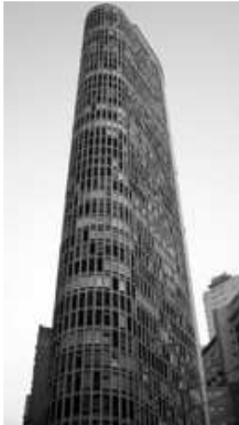
Foto 108 – Edifício Itália: detalhe da torre Fonte – Foto da autora, 2006
