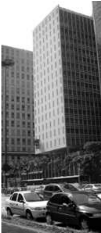
Foto 115 – Edifício Sul-Americano: fachada Fonte – Foto da autora, 2006
