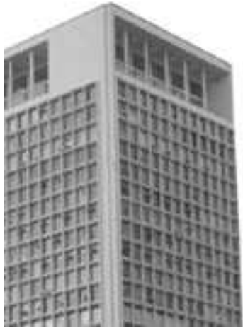
Foto 106 – Edifício CBI Esplanada: detalhe dos pavimentos recuados Fonte – Foto da autora, 2006
