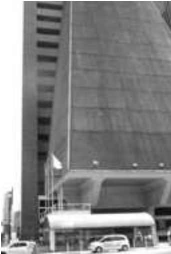
Foto 117 – Edifício FIESP: fachada
