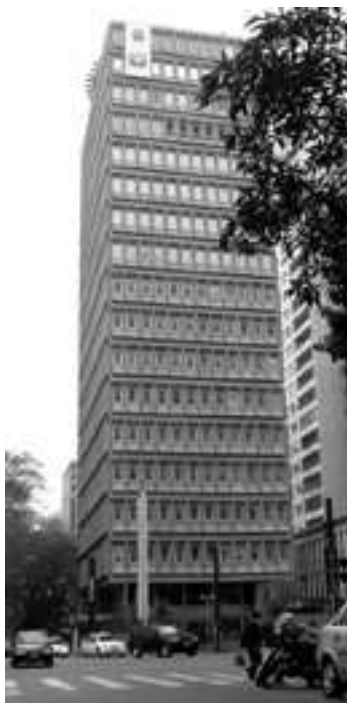
Foto 63 – Verticalização do milagre (1967-1971): o Edifício de Escritórios do Banco Panamericano (antiga Sede da CBPO, 1968), projeto de R. N. Rocha Diniz e Sidônio Porto, é um exemplo deste período Fonte: Foto da autora, 2006.
