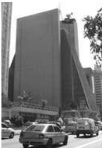
Foto 116 – Edifício FIESP: fachada
