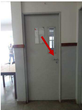
Figura 100: Porta de sala de aula com maçaneta do tipo alavanca. Fonte: Amanda Félix
