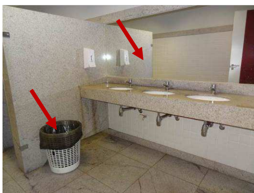
Figura 110: Banheiro masculino do bloco 1. Destaque para a lixeira mal posicionada e para o espelho.
