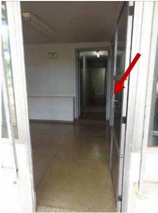
Figura 84: Entrada do subsolo do bloco 7. Porta com largura de 80cm livres, em nível com a área externa. Ao fundo a entrada do corredor rampado.
