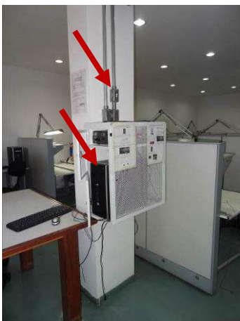
Figura 120: Bloco 4, ateliê 2, sala 4002.
