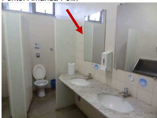
Figura 114: Banheiro masculino da sala dos professores do bloco 7. Detalhe do espelho.
