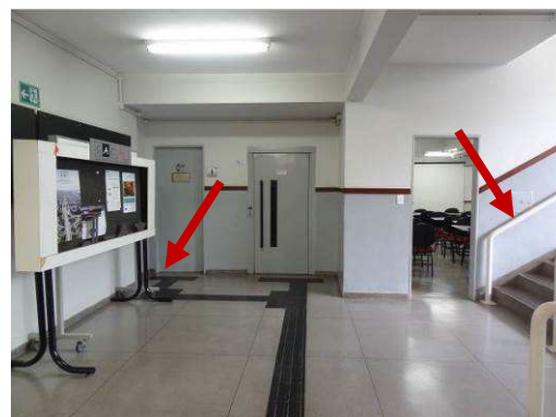
Figura 87: Rota de acesso interna do bloco 8, pavimento térreo. Destaque para o percurso da sinalização da rota acessível até o banheiro e o
