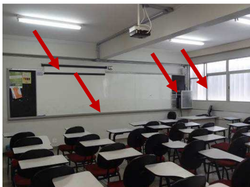
Figura 126: Sala 8100. Destaque para o telão, o quadro branco e o interruptor dos equipamentos fora das alturas de alcance e para as janelas acessíveis. Fonte: Amanda Félix
