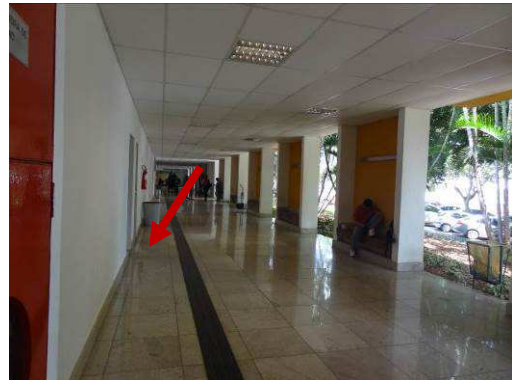
Figura 76: Indicação das sinalizações direcionais nas rotas acessíveis. O detalhe mostra que algumas salas não estão sinalizadas.
