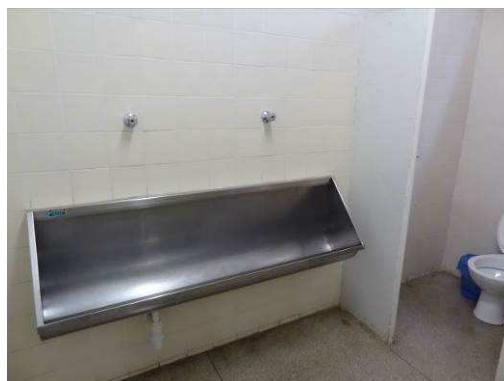
Figura 115: Banheiro masculino da sala dos professores do bloco 7. Detalhe do mictório.
