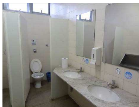
Figura 41: Banheiro masculino da sala dos professores, no bloco 7. Fonte: Amanda Félix
