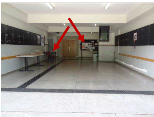
Figura 86: Rota de acesso interna do bloco 8, entrada frontal. Destaque para os obstáculos na sinalização direcional da rota acessível.
