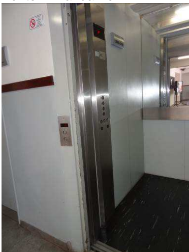
Figura 95: Cabina interna do elevador do bloco 8. Detalhe dos botões de acesso. Fonte: Amanda Félix
