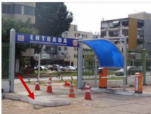
Figura 61: Rota S2, acesso do estacionamento pago do campus, com detalhe para a passagem dos pedestres e da falta de uma rota acessível. Fonte: Amanda Félix
