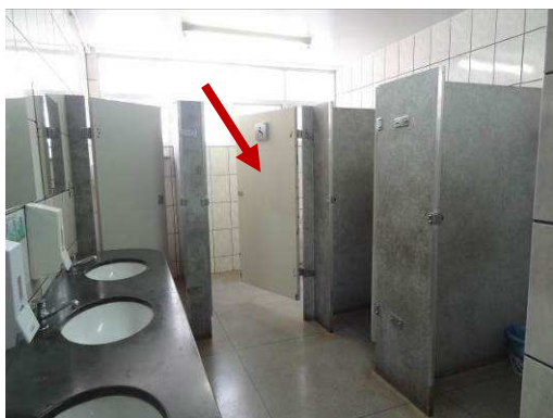
Figura 116: Banheiro feminino do bloco 8. Destaque para a porta abrindo para o lado interno do box.
