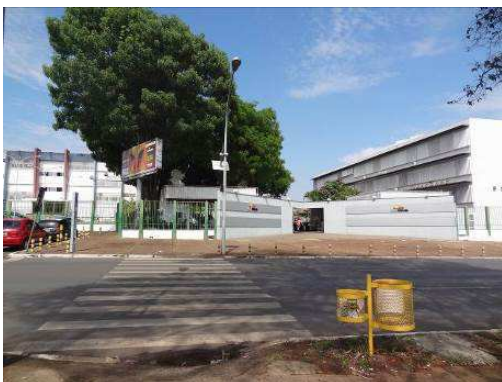
Figura 59: Rota P1, acesso pela via W4 Norte, sem semáforos e sinalização sonora. Destaque para a calçada rebaixada e a lixeira acessível. Fonte: Amanda Félix
