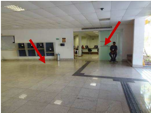
Figura 75: Indicação das sinalizações direcionais nas rotas acessíveis. O detalhe mostra que o percurso até os telefones não está sinalizado no piso e que a porta de vidro está devidamente sinalizada.
