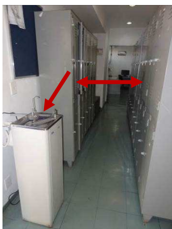
Figura 79: Corredor de acesso aos ateliês do pavimento térreo. Circulação de 85cm e bebedouro inacessível. Fonte: Amanda Félix
