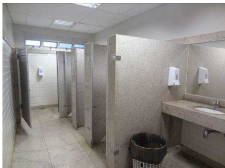
Figura 38: Banheiro feminino do bloco 1. Fonte: Amanda Félix
