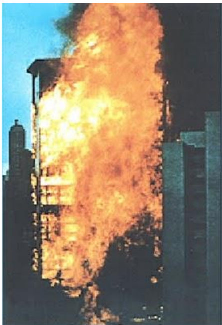
Figura 02 – Edifício Andraus durante e após o incêndio
