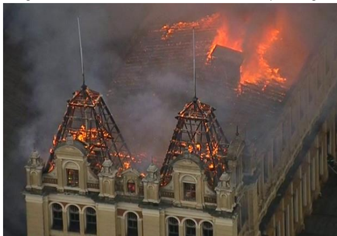
Figura 4 – Cobertura totalmente destruída pelo fogo
