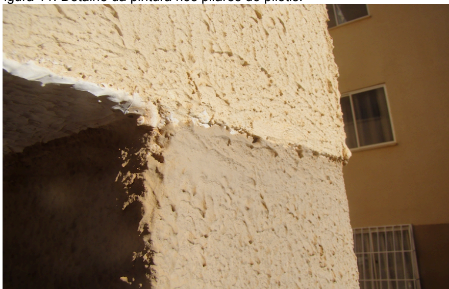
Figura 11: Detalhe da pintura nos pilares do pilotis.
