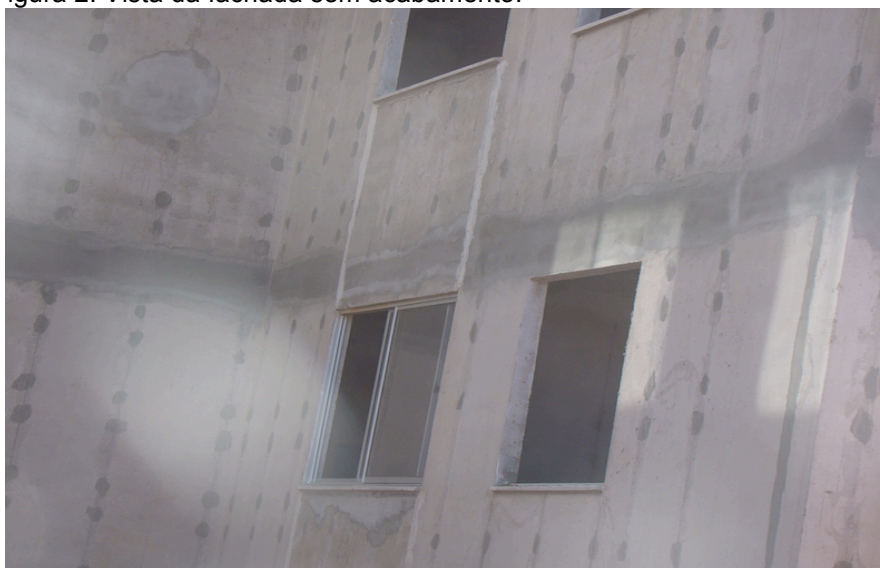
Figura 2: Vista da fachada sem acabamento.
