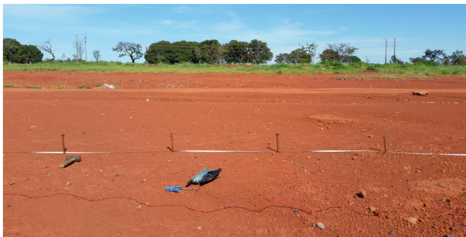
Figura 3.2 – Realização das medições no St. de Grandes Áreas Norte
