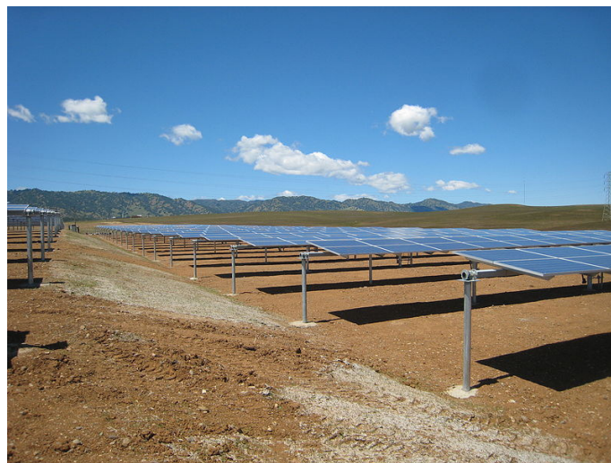
Figura 2.5 - Seguidor Solar de único eixo horizontal Fonte: WIKPÈDIA
