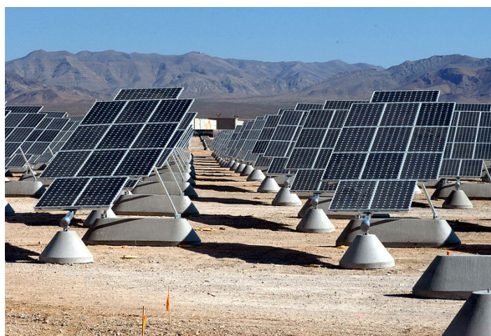
Figura 2.9 - Seguidores de único eixo com inclinação de 20° em Nellis Air Force Base - Nevada-USA Fonte: WIKIPÈDIA
