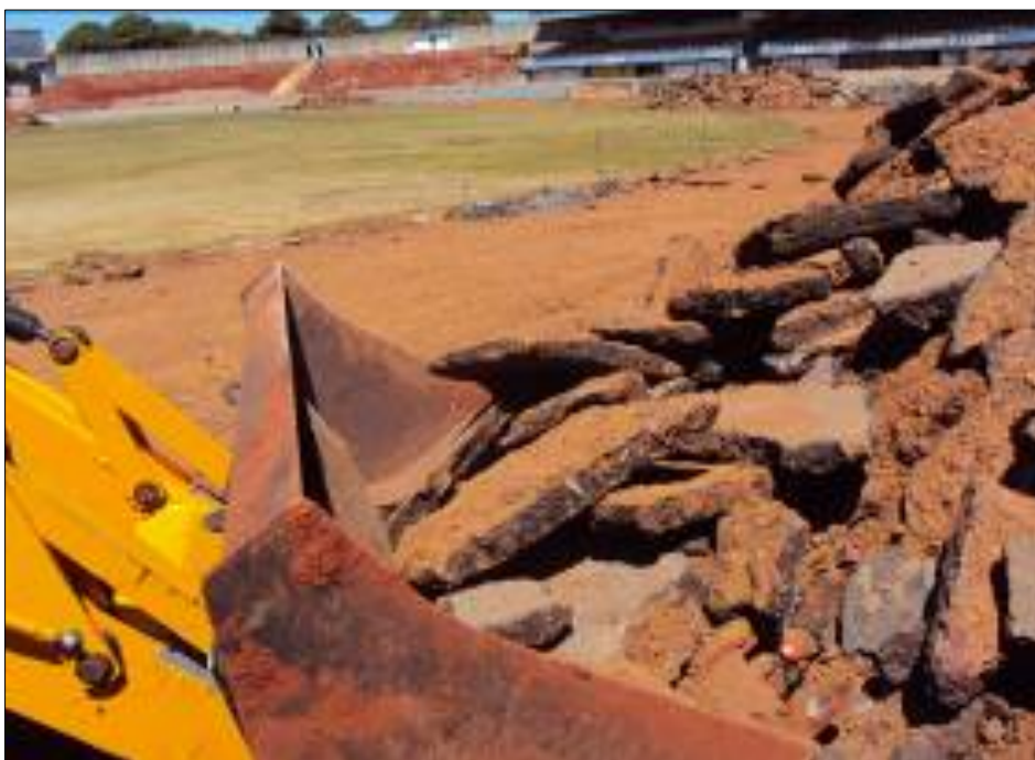
Figura 4.6 - Pista de atletismo em CBUQ sendo retirada.
