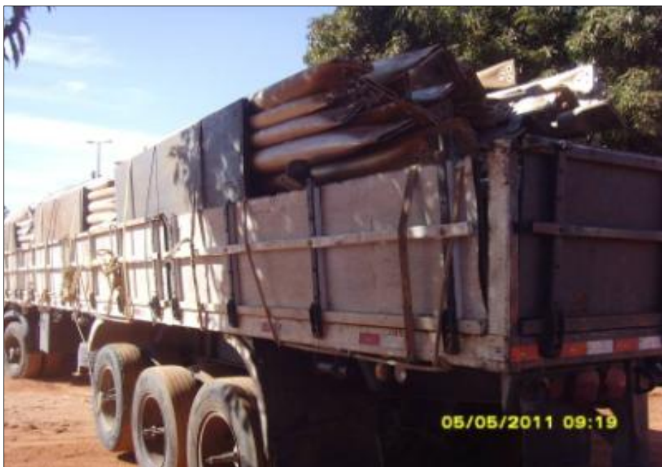
Figura 4.13 - Estrutura metálica da antiga cobertura em transporte.
