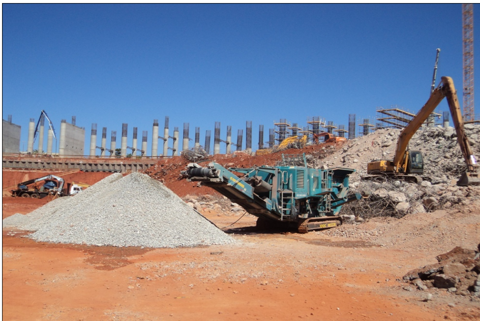
Figura 4.11 - Britagem sendo realizada dentro do canteiro.
