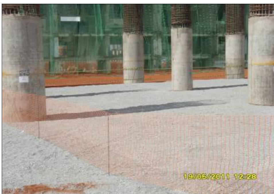
Figura 4.5 - Área de trabalho com brita reciclada (lastro).
