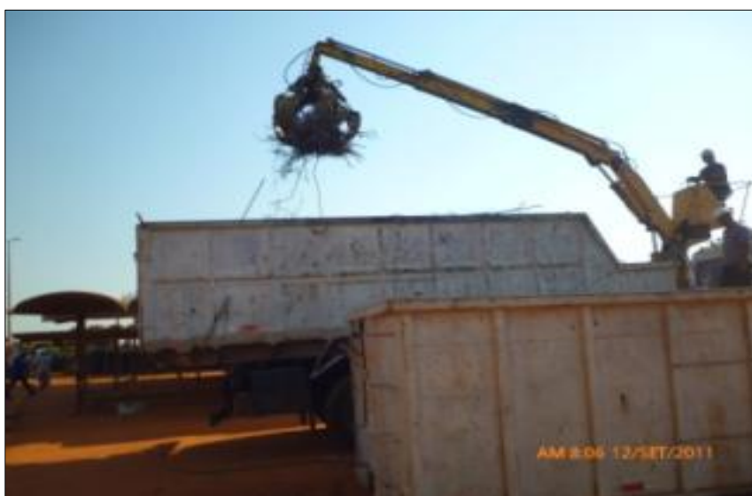
Figura 4.19 - Caminhão sendo carregado diretamente no canteiro.
