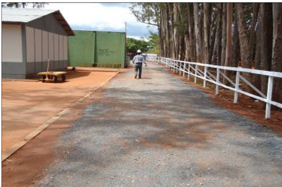
Figura 4.4 - Acesso ao canteiro com brita proveniente de reciclagem.
