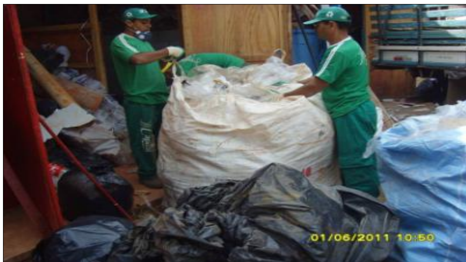
Figura 4.16 - Colaboradores realizando a triagem de RCC.
