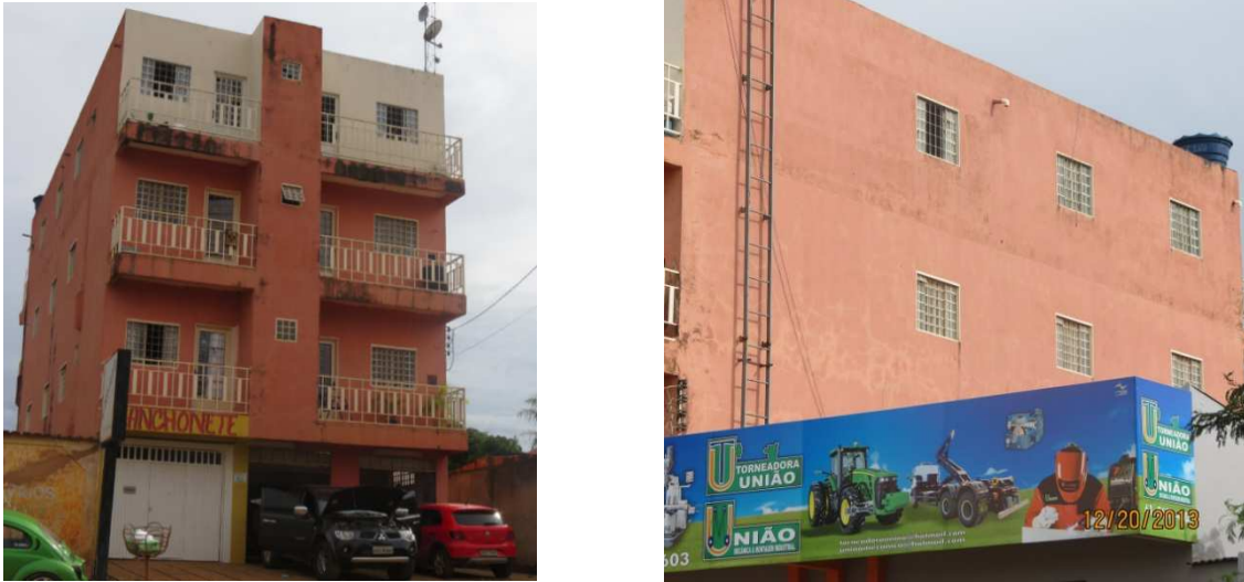
Figura 25 – Fachada frontal do edifício D e fachada lateral direita do edifício D
