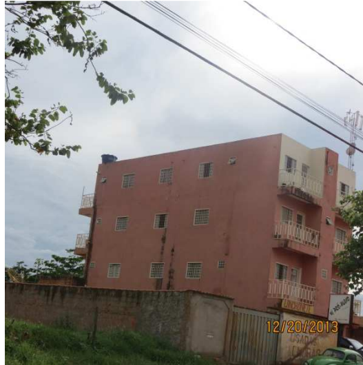
Figura 26 – Fachada lateral esquerda do edifício D
