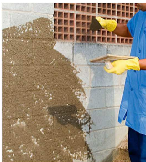
Figura 2 - Aplicação de chapisco convencional
