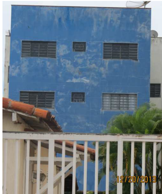
Figura 17 - Fachada posterior do edifício A
