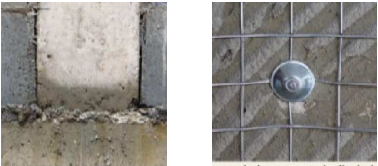
Figura 5 – Encontro da alvenaria com a estrutura e tela metálica
