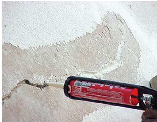
Figura 14 – Aplicação de selante base acrílico em 1ª demão
