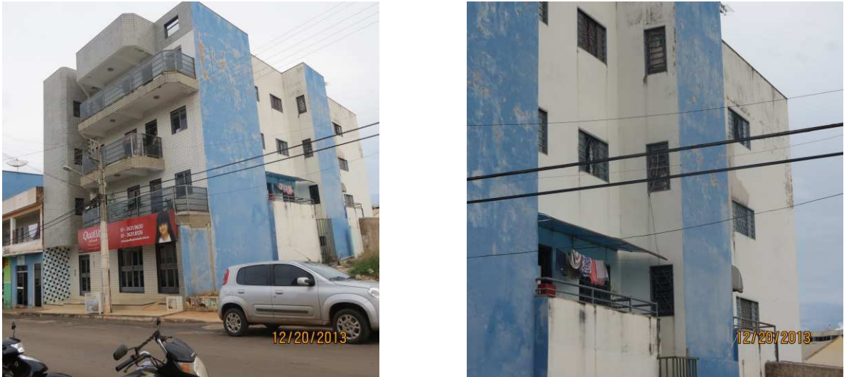
Figura 16 - Fachada frontal do edifício A e fachada lateral direita do edifício A
