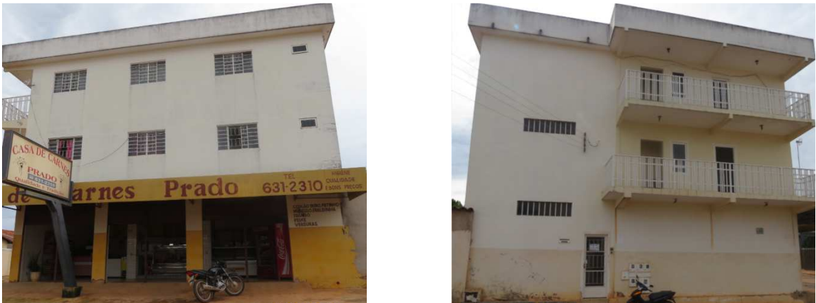
Figura 19 – Fachada frontal do ed .B e fachada lateral esquerda do edifício B
