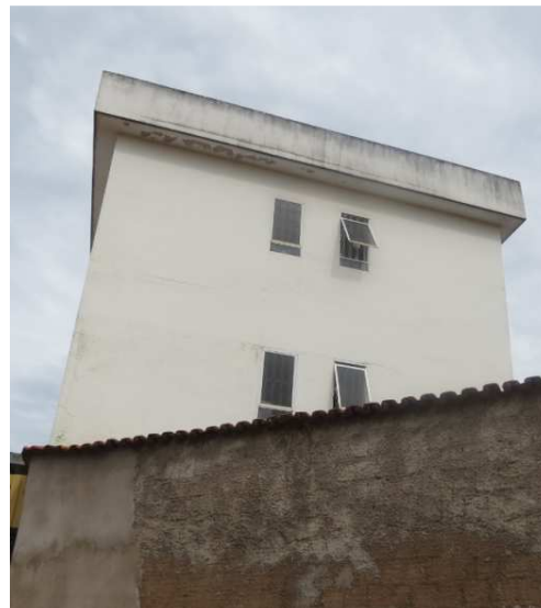
Figura 20 – Fachada lateral direita do edifício B
