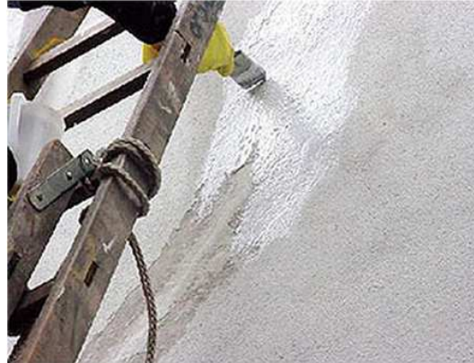
Figura 15 – Aplicação de 1ª demão de impermeabilizante acrílico
