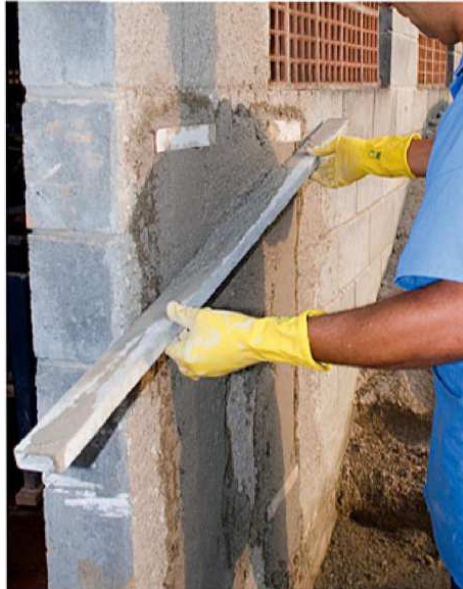
Figura 3 - Sarrafeamento do emboço entre as faixas-mestras
