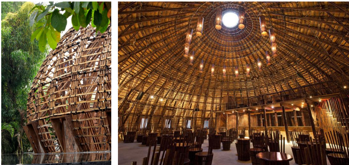
FIGURA 5a e 5b: Wind and Water Bar – Estrutura em bambu (Binh Doung – Vietnã)
