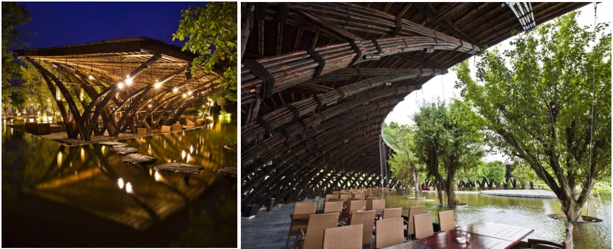
FIGURA 7a e 7b: Bamboo Wing – Cobertura de Bambu (Dai Lai Resort – Vietnã)
