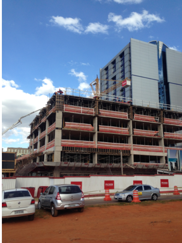
Figura 8: vista da obra com grua
