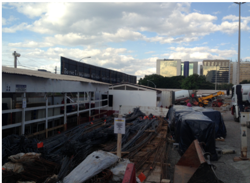
Figura 7: canteiro de Obras Fonte: arquivo pessoal
