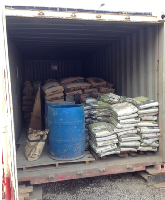
Figura 14: canteiro de Obras (argamassas)
