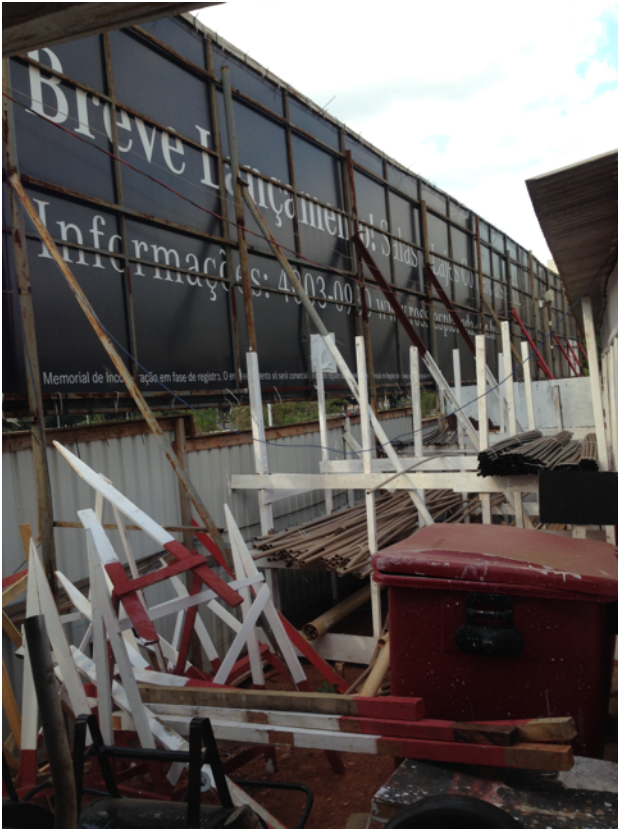
Figura 9: canteiro (tubos PVC) Fonte: arquivo pessoal
