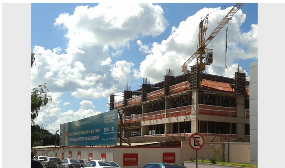
Figura 2: Obra atual (maio/2014) Fonte: arquivo pessoal
