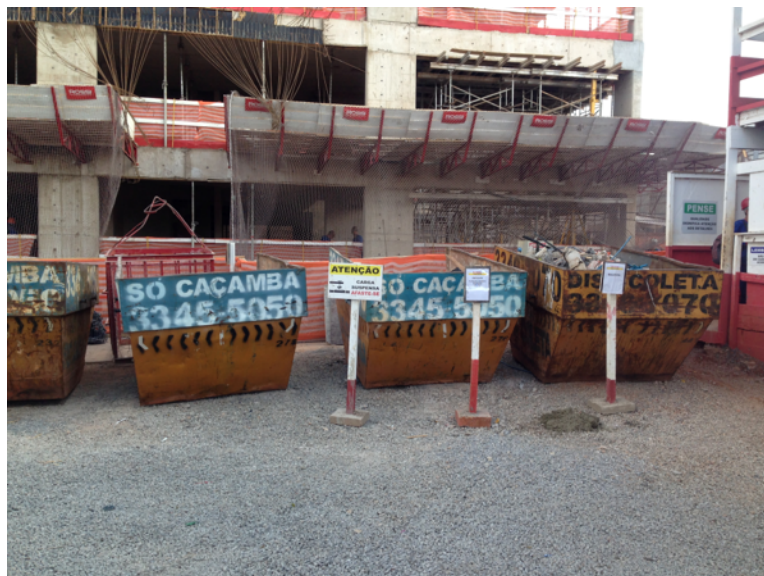
Figura 15: canteiro de Obras (entulho)
