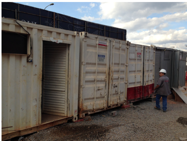
Figura 13: canteiro de Obras (containers)
