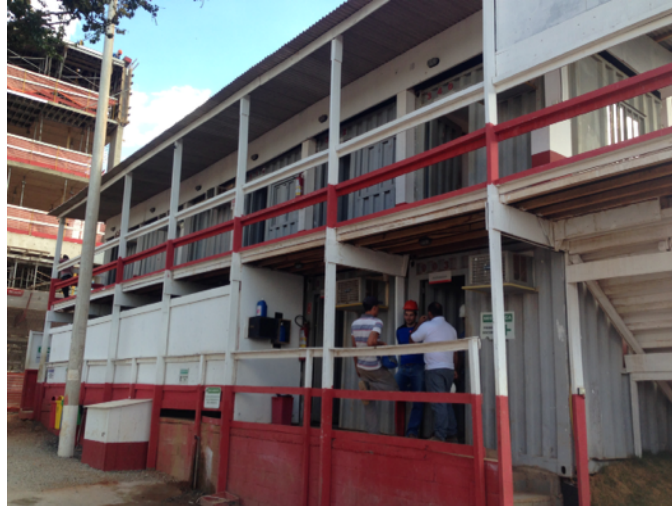
Figura 6: Canteiro de Obras (administração) Fonte: arquivo pessoal
