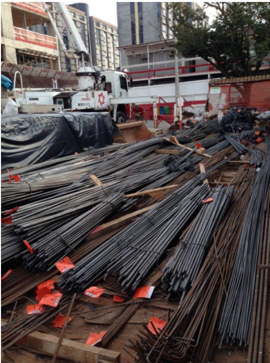
Figura 11: canteiro (aço) Fonte: arquivo pessoal
