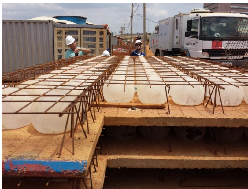
Figura 15 – Lajes bubble deck montadas para a utilização, no Centro Administrativo de Brasília-DF.
