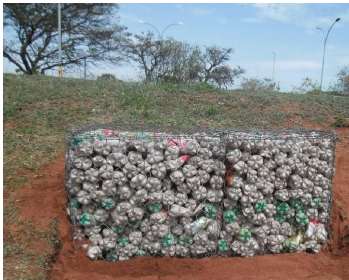
Figura 20 - Gabião feito com garrafas PET preenchidas com agregado de RCD.
