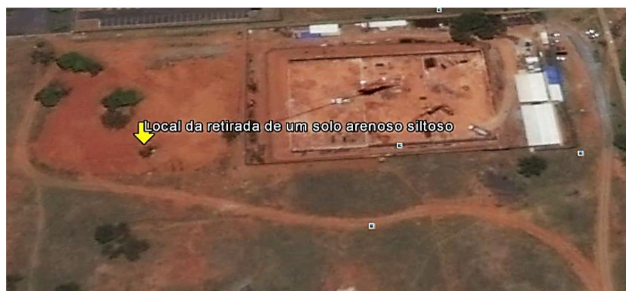
Figura 14 – Vista superior do local da obra
