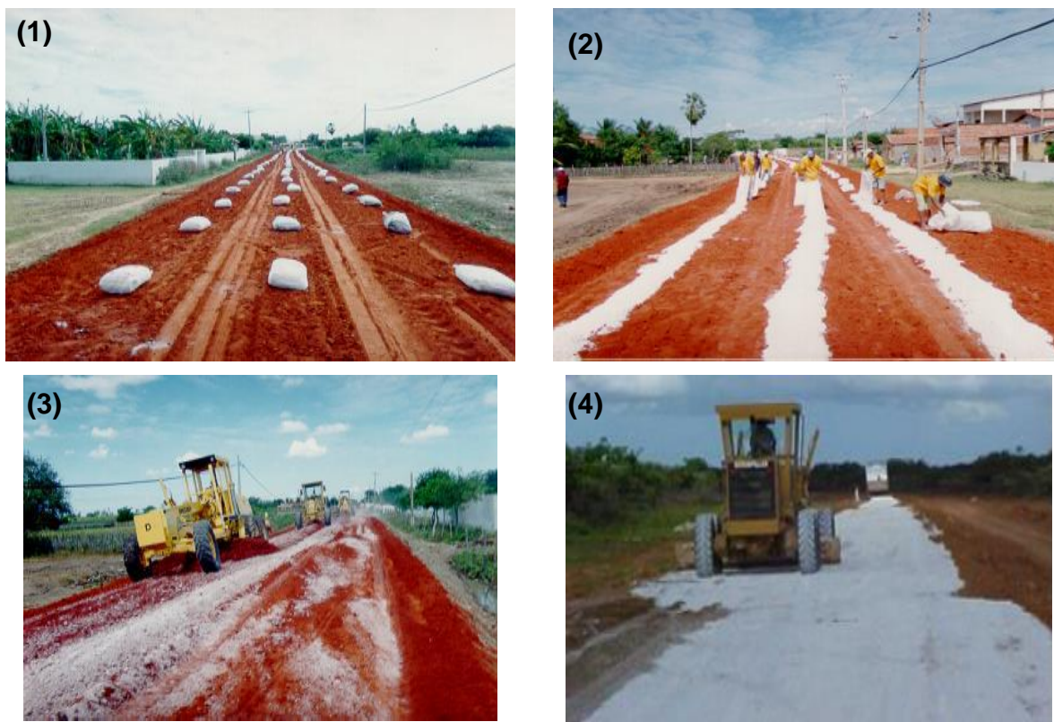
Figura 12 – Etapas da estabilização de solos com cal
