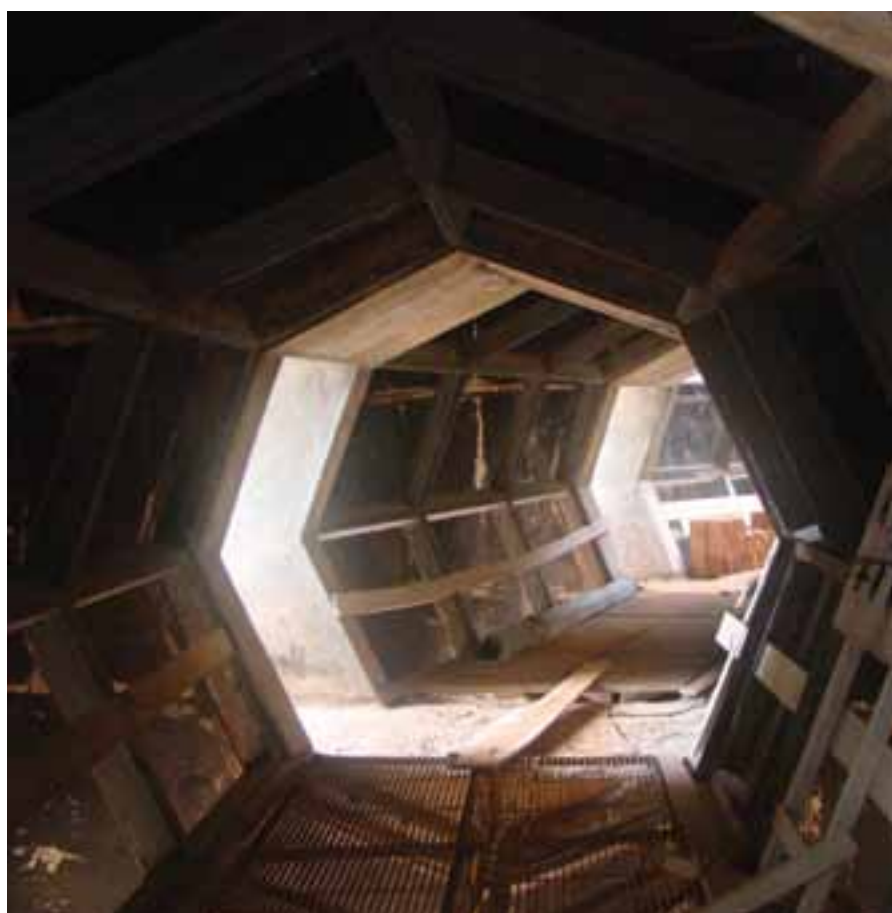
Parte interna do planetário em reforma.
