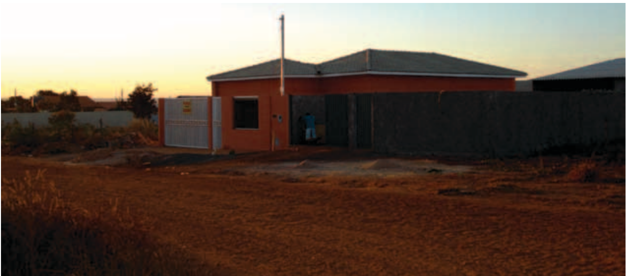
Casa em rua sem asfalto não podem ser financiadas pela Caixa
