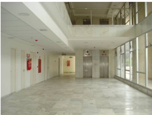
Figura 47: Circulação central com forro adaptado do HBDF - SES DF, ar condicionado em sanca aparente com altura de 35 cm
