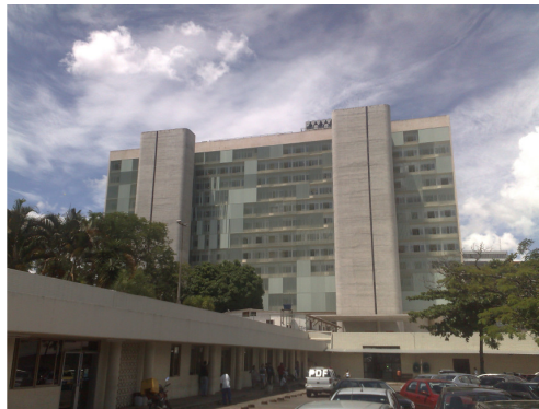
Figura 35: Vista da central do sistema de ar condicionado na cobertura no HBDF - SES DF
