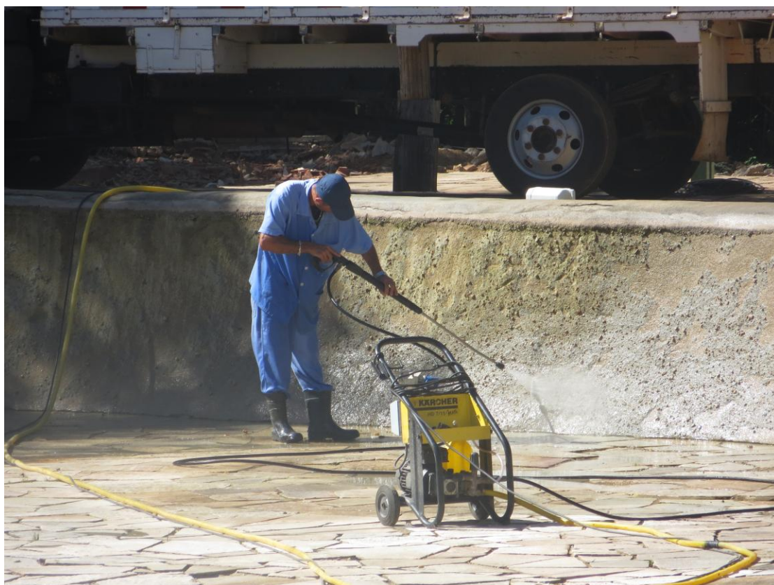
Figura 17: Limpeza da piscina Velha no Parque Nacional de Brasília.
