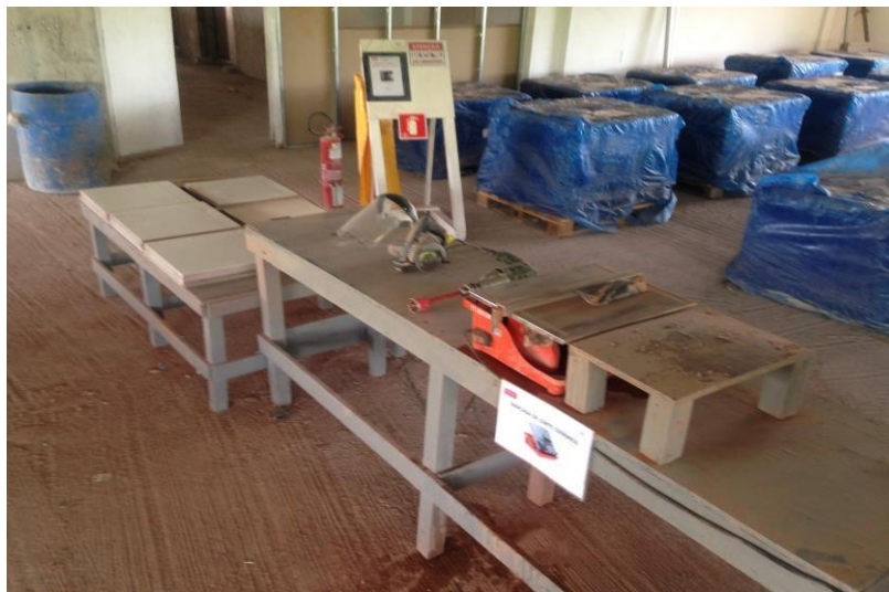
Imagem 1: Local de corte de cerâmica, material devidamente estocado
