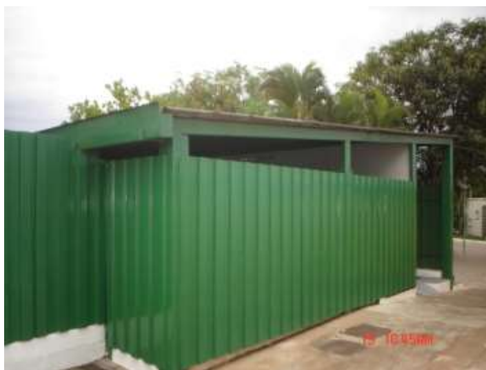
Figura 3 – Detalhe lateral da cobertura de amianto
