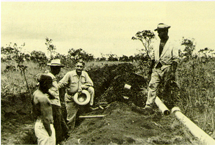
Figura 10. Primeiras canalizações de água em Brasília
