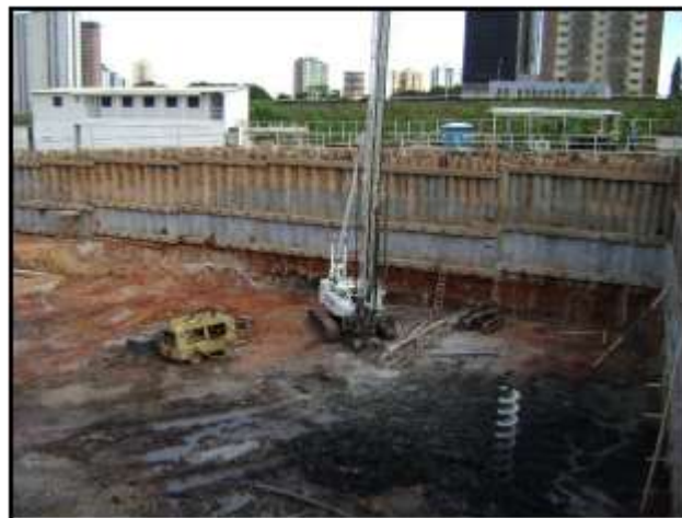
Figura 4. Visão geral da contenção (lado sul)
