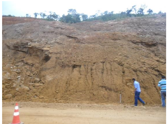
Figura 11. Vista geral da área do Corte 127.
