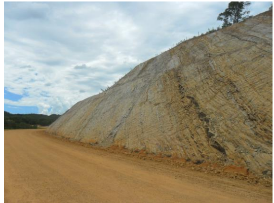
Figura 10. Vista geral da área do Corte 126.
