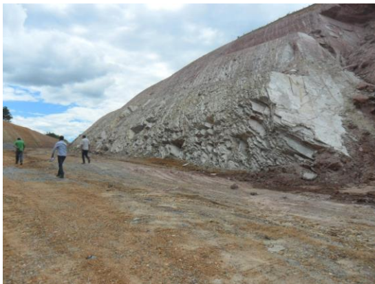
Figura 8. Vista do talude do Corte 119.
