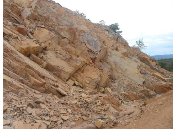
Figura 9. Vista geral da área do Corte 120.
