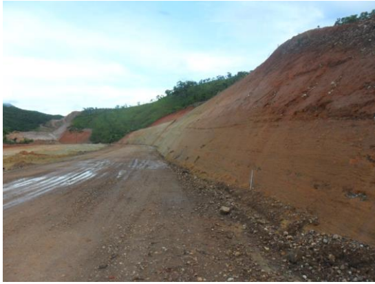
Figura 5. Vista do talude do Corte 112.
