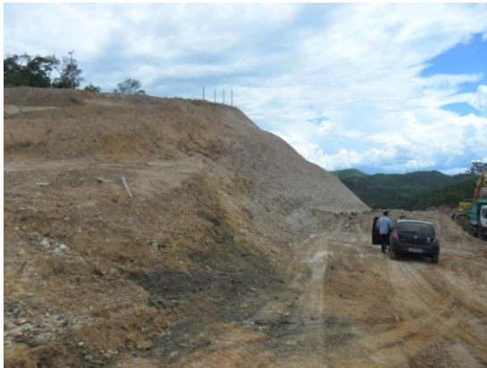
Figura 6. Vista do talude do Corte 114.
