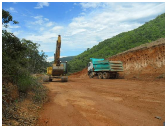
Figura 1. Vista do talude do Corte 107.
