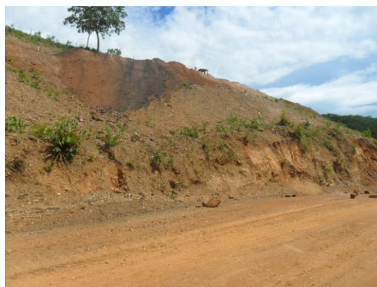
Figura 2. Vista do talude do Corte 108.
