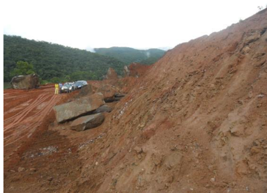
Figura 4. Vista do talude do Corte 111.
