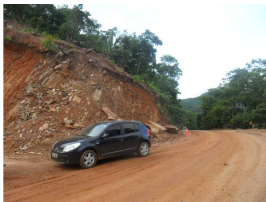
Figura 3. Vista do talude do Corte 110.
