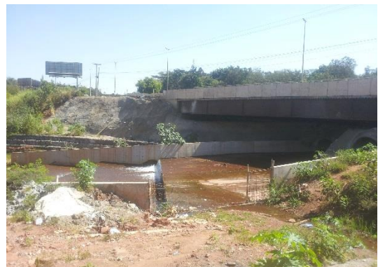
Figura 16. Vista da obra finalizada.
