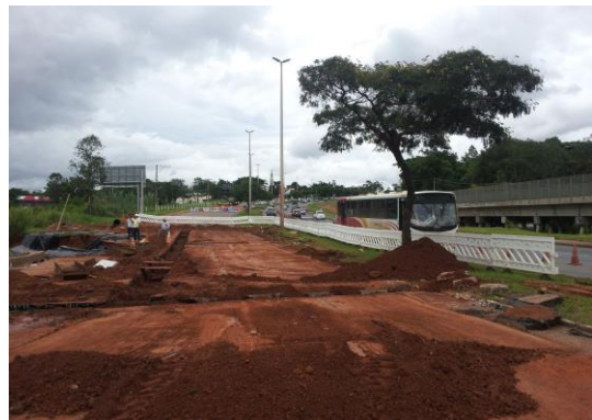
Figura 13. Vista da obra para recuperação do trecho erodido.
