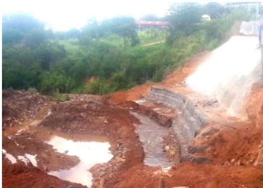
Figura 11. Obra de recuperação do talude, em gabião, solo grampeado e concreto projetado.
