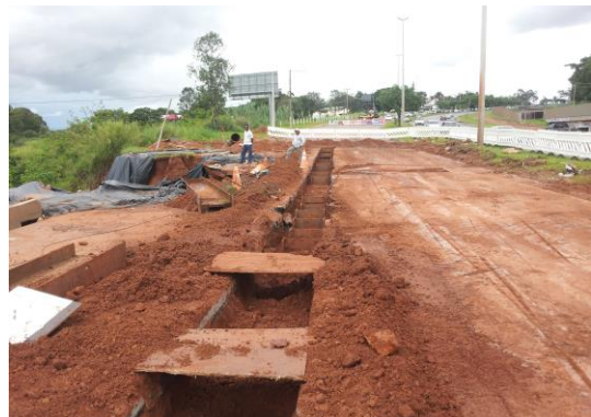
Figura 14. Vista da obra. Observar a linha de perfil metálico executada.
