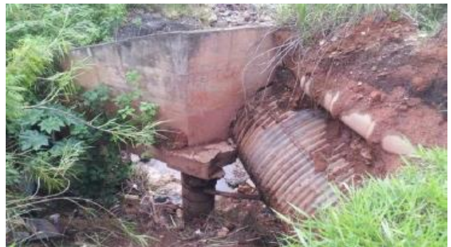
Figura 5. Área em processo de ruptura.
