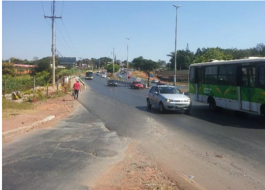
Figura 17. Pista com a obra finalizada.
