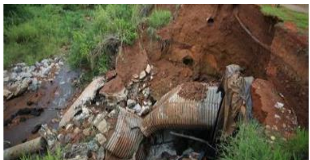
Figura 6. Área após processo de ruptura.
