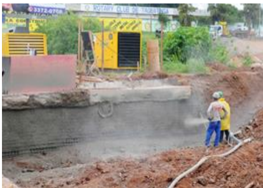
Figura 12. Obra de recuperação do talude. Aplicação de concreto projetado.
