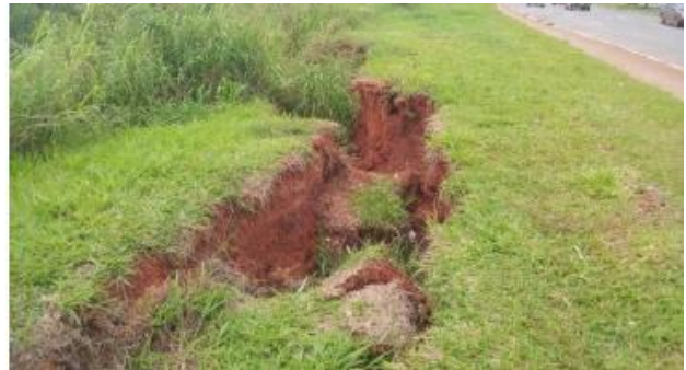
Figura 4. Talude em processo de ruptura.
