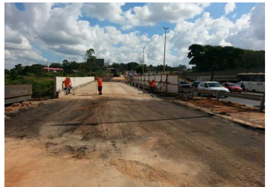
Figura 15. Pista lateral executada após cravação da linha de perfis metálicos.
