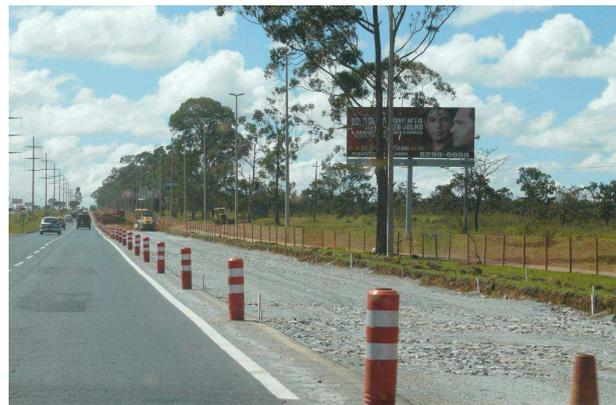
Figura 5. Seção tipo da camada de Rachão.
