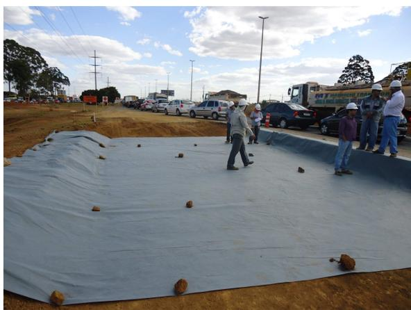
Figura 9 – Aplicação do Geotêxtil.
