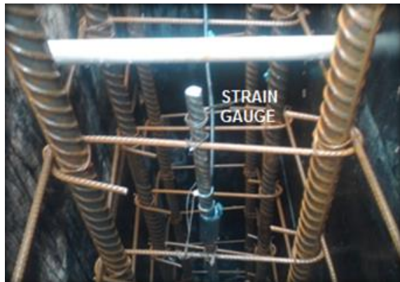
Figura 3.3 Strain Gauge instalado nos pilares
