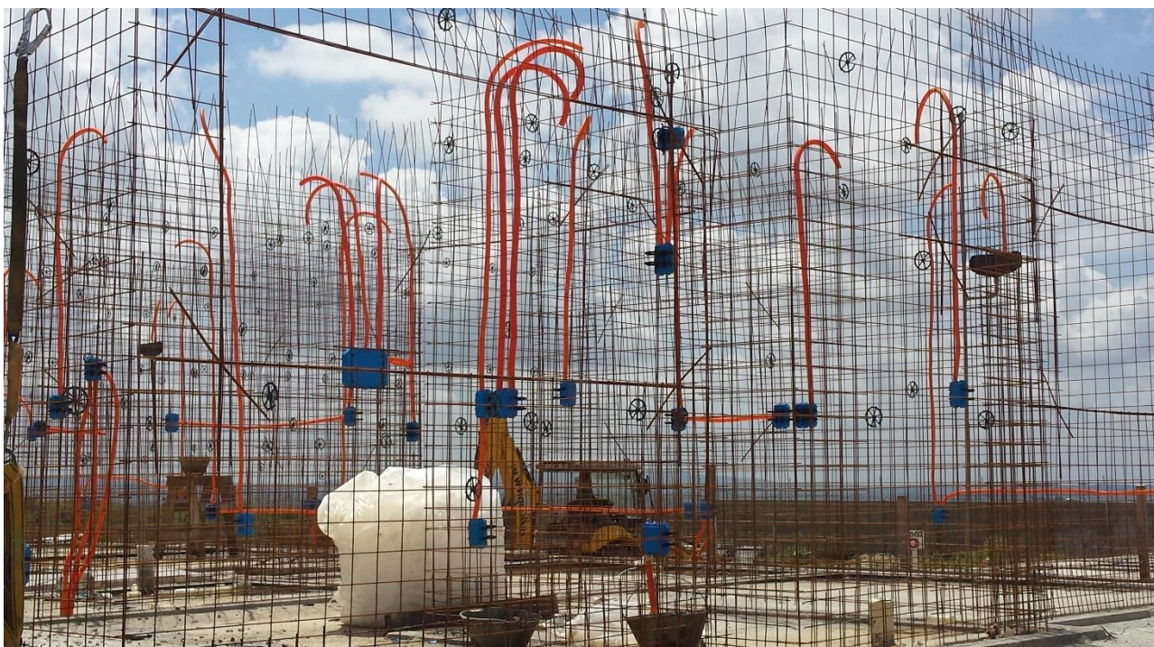
Figura 8 – Espaçadores nas telas de aço
