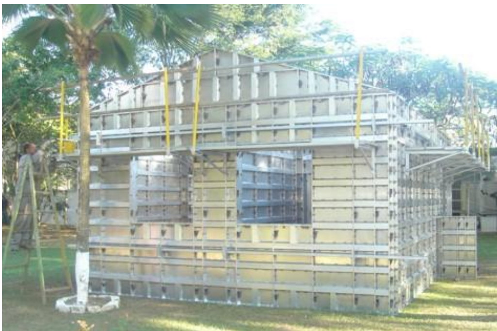
Figura 11 – Fôrmas de alumínio montadas
