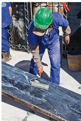
Figura 10 – Aplicação de Desmoldante à base de água e parafina líquida
