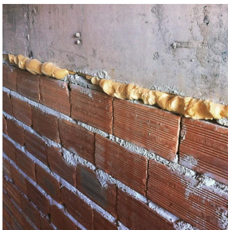
Figura 4 – Encunhamento de Alvenaria
