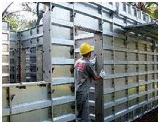
Figura 5 – Fôrmas de Alumínio já executadas
