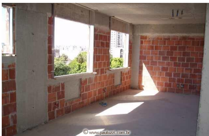
Figura 1 – Alvenaria de Vedação com Blocos Cerâmicos
