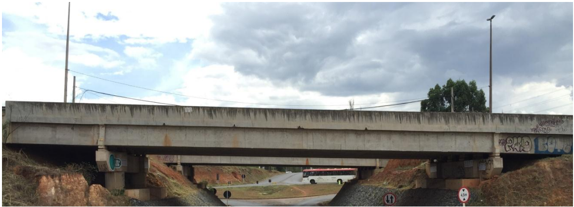
Figura 4-2 Vista frontal da AOE 1
