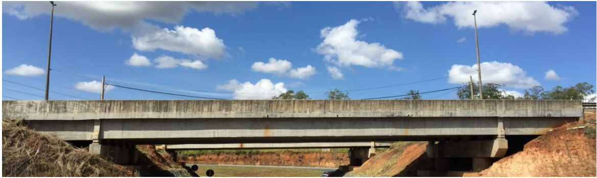
Figura 4-16 Vista frontal da AOE 2
