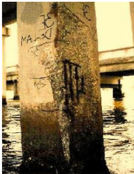
Figura 2-13 Pilar de ponte em região marítima
