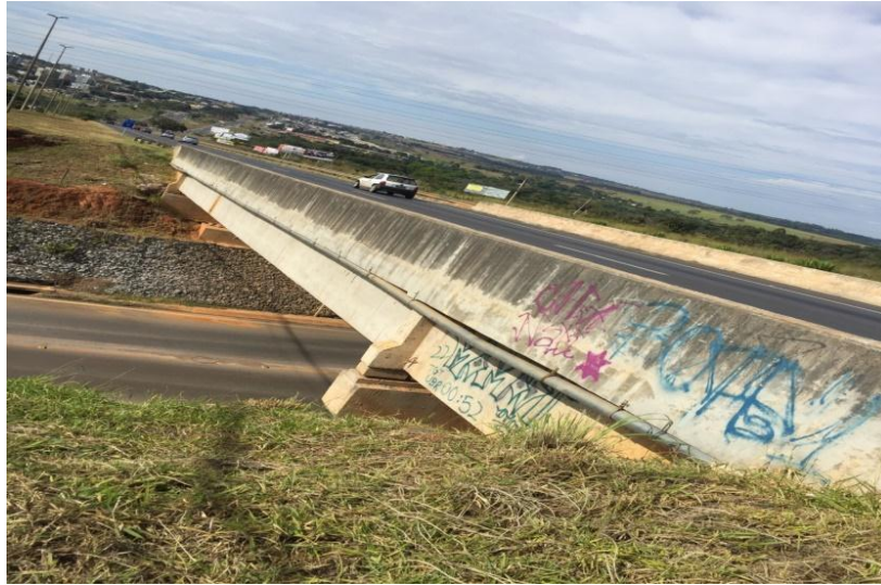
Figura 4-15 Barreira lateral esquerda, sentido Plano-Sobradinho
