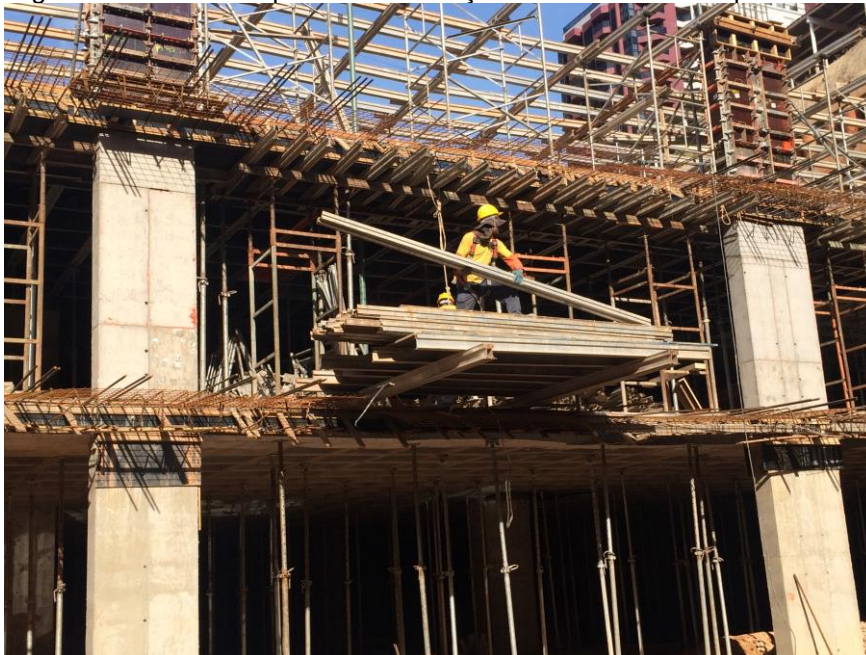
Figura 43. Plataforma para movimentação de materiais entre pavimentos
