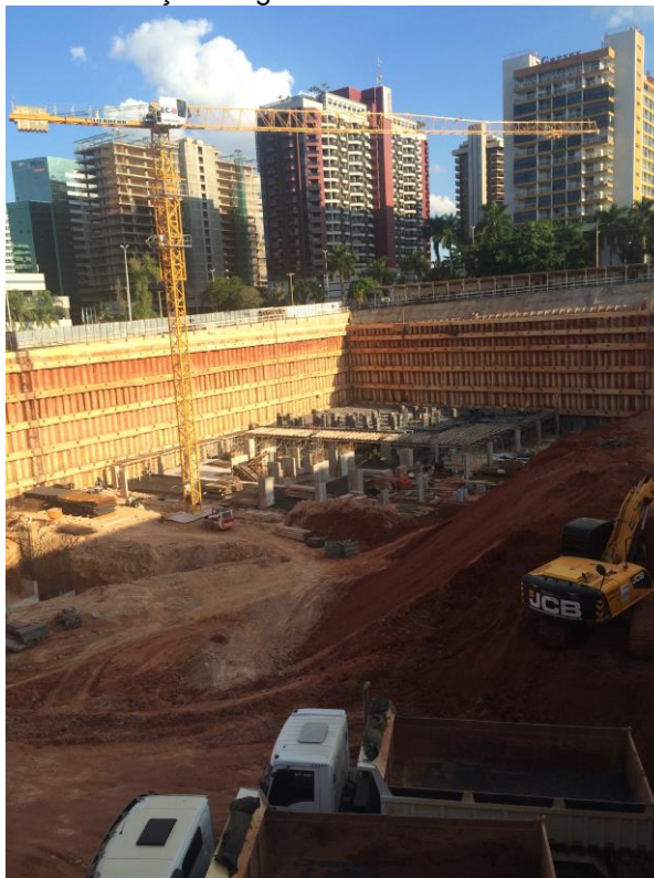
Figura 40. Localização da grua e início da estrutura da torre B
