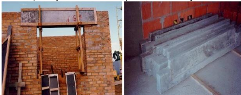
Figura 17. Simplificação do número de passos na execução de alvenaria
