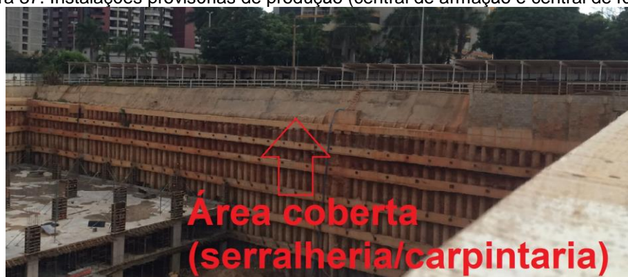
Figura 37. Instalações provisórias de produção (central de armação e central de fôrmas)
