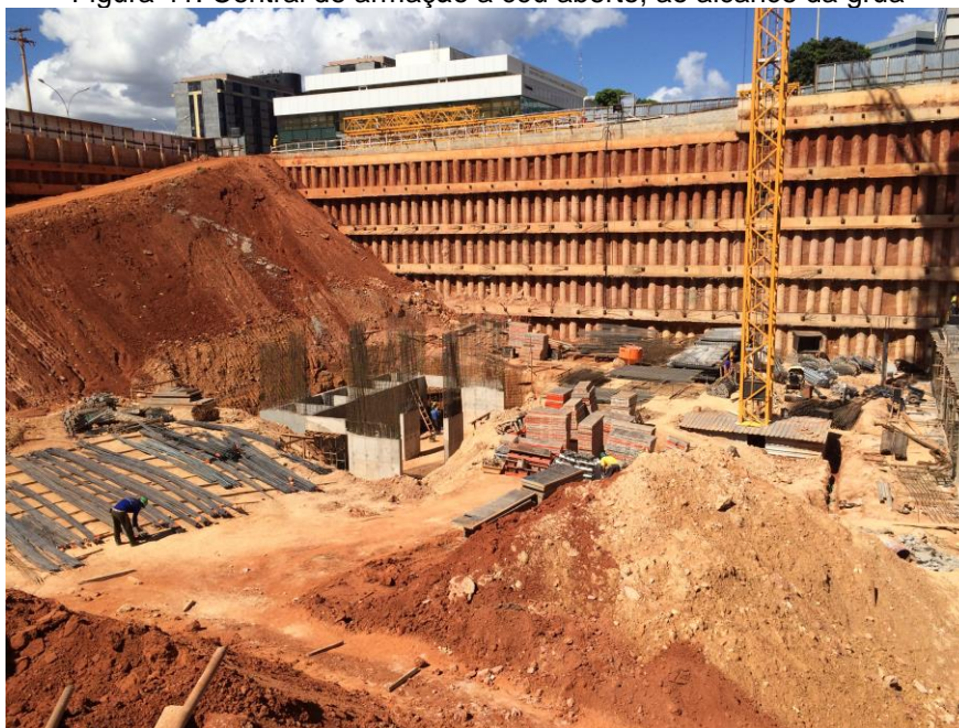
Figura 41. Central de armação a céu aberto, ao alcance da grua
