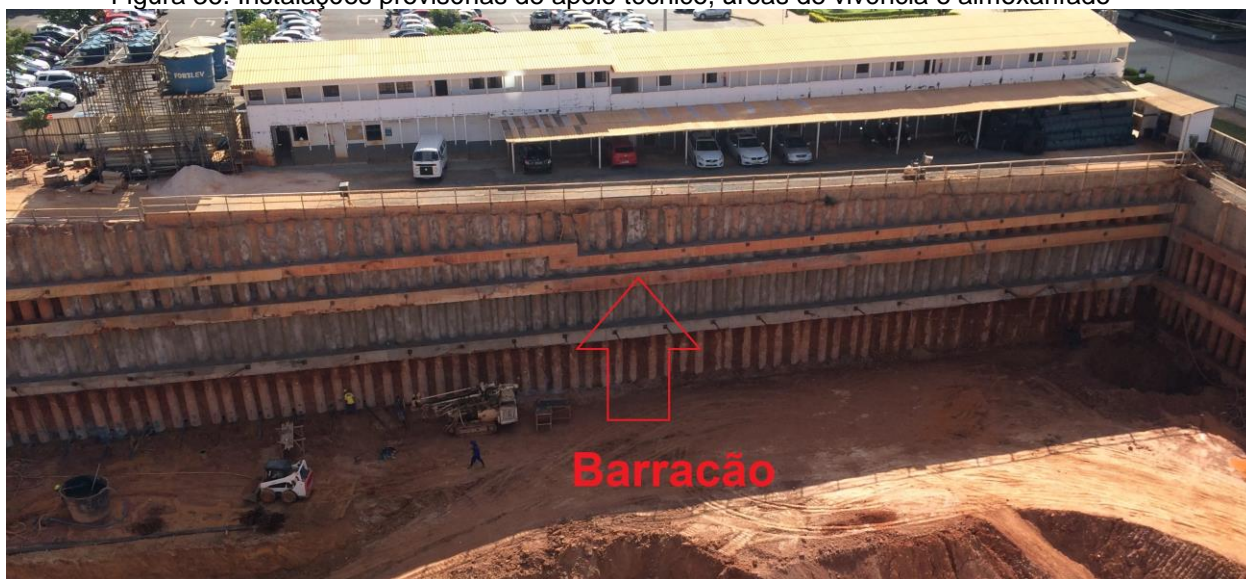
Figura 36. Instalações provisórias de apoio técnico, áreas de vivência e almoxarifado
