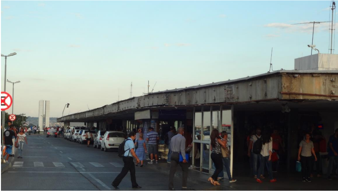
Imagem 10: Fachada lateral da Cobertura da Plataforma Superior da Rodoviária de Brasília
