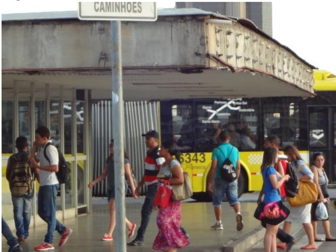
Imagem 9: Detalhe de um dos vértices da Cobertura da Plataforma de Rodoviária de Brasília
