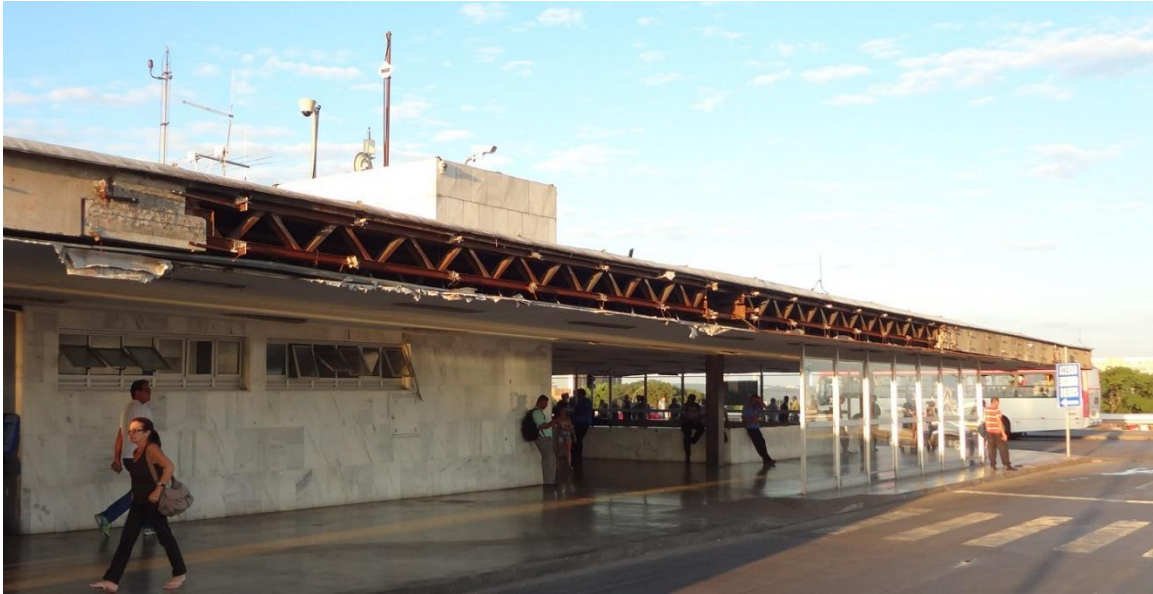
Imagem 16: Detalhe de um reparo feito na Cobertura da Plataforma da Rodoviária do Plano Piloto com a substituição das vigas em concreto por treliças metálicas
