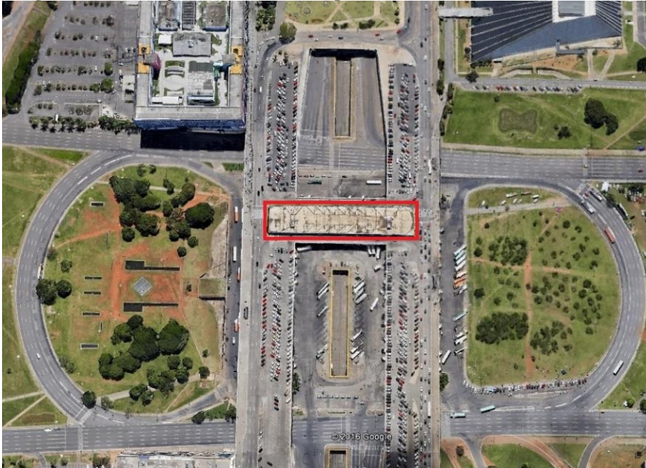
Imagem 2 – Localização da Plataforma Superior da Rodoviária de Brasília
