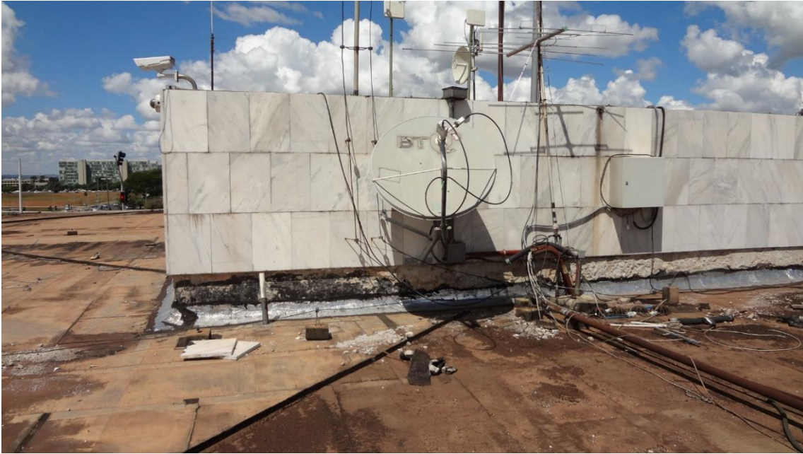
Imagem 12: Detalhe das instalações e da impermeabilização da laje de concreto com manta asfáltica aluminizada
