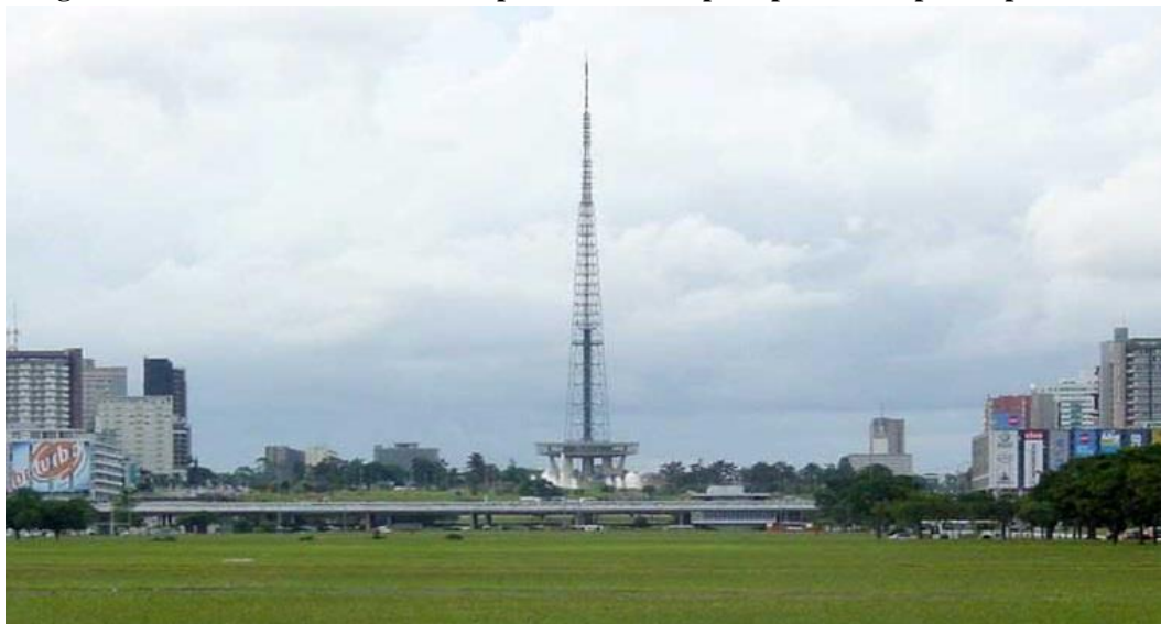
Imagem 3 – Plataforma da Rodoviária praticamente imperceptível vista pela Esplanada dos Ministérios
