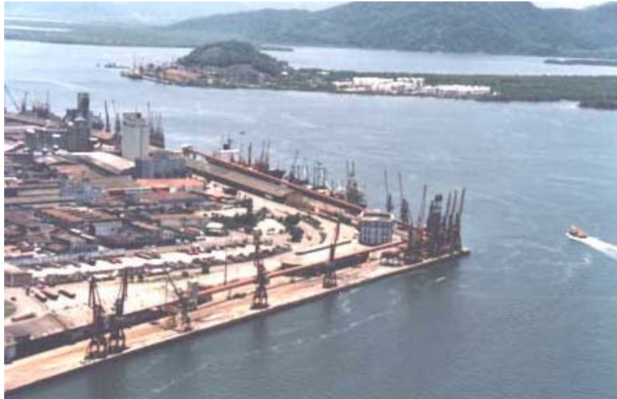
Moinho Santista - Terminal de Descarga para Sólidos a Granel
