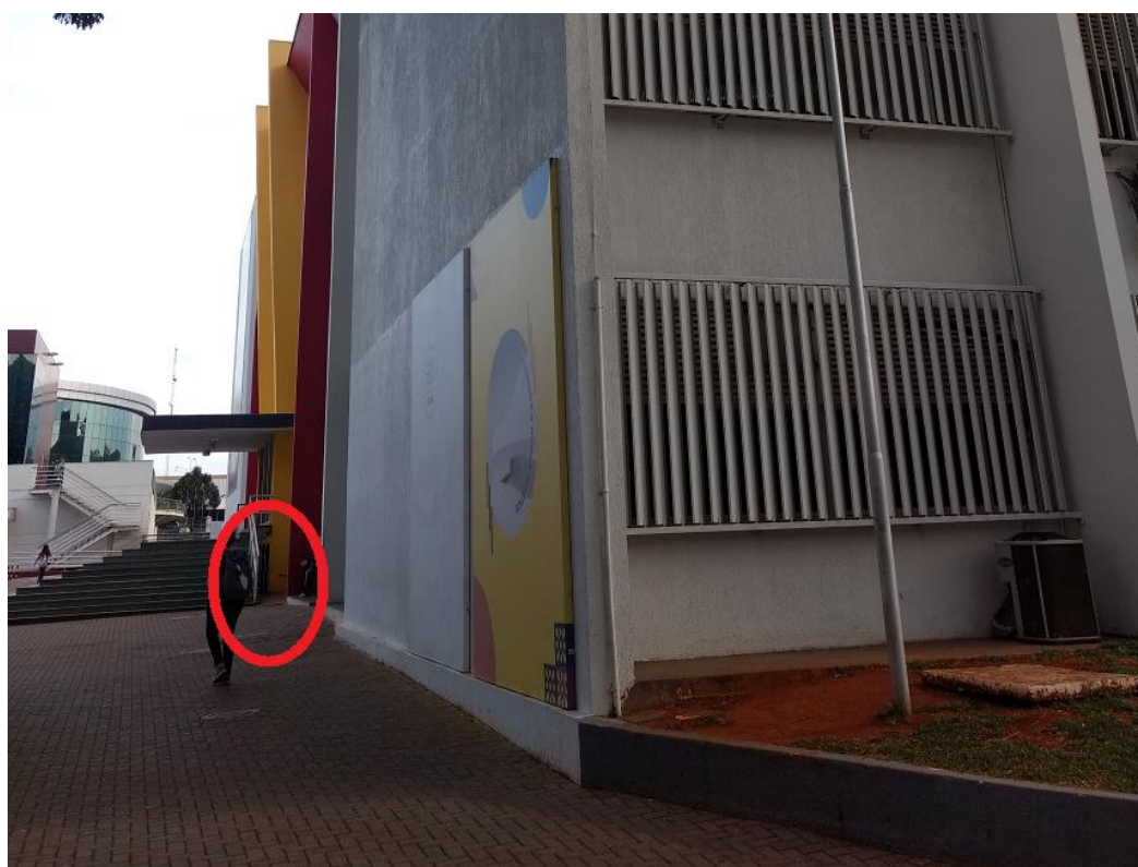
Figura 3.17 – Localização da passagem do cabo do subsistema de aterramento do bloco 3
