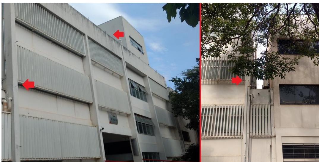
Figura 3.6 – Localização da malha removida e das descidas frontais do Bloco Único
