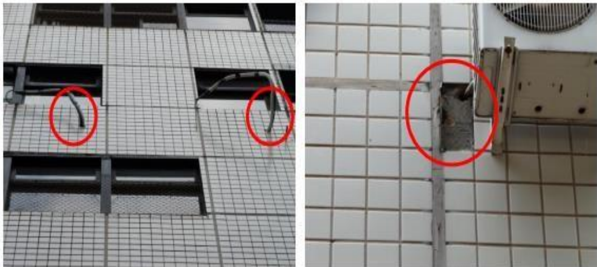
Figura 13 - Retirada de ceramica para o uso de ar condicionados.
