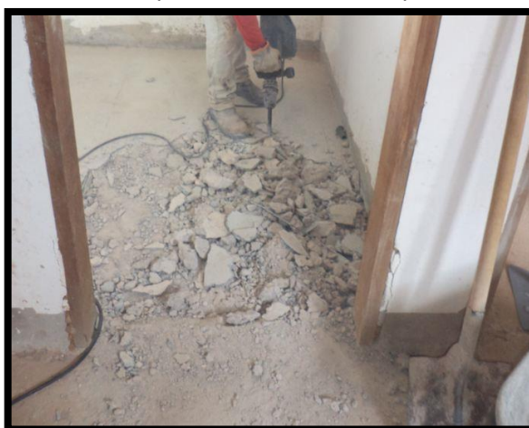
Figura 24 - Foto do contrapiso sendo retirado no pavimento térreo
