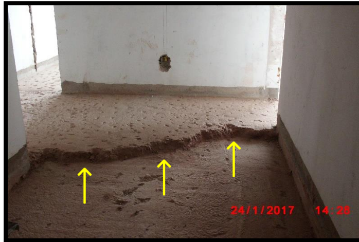
Figura 14 - Foto do contrapiso executado
