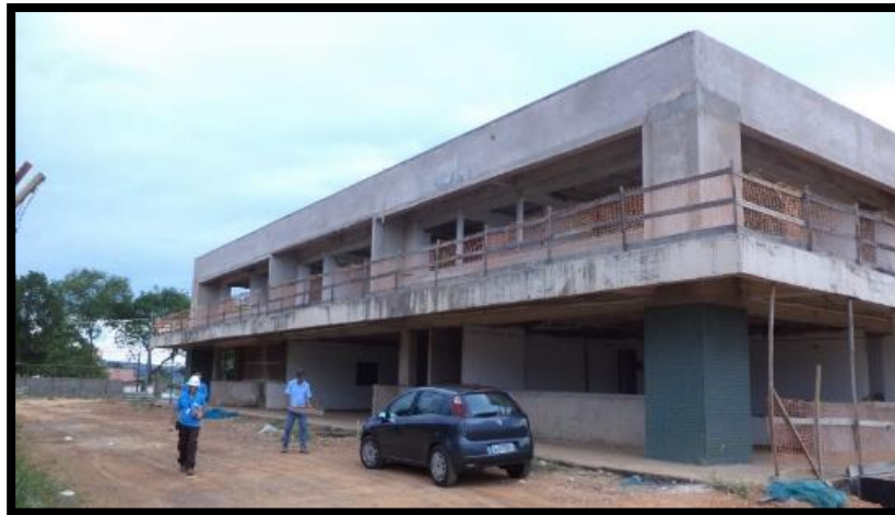
Figura 4 - Fachada frontal do prédio no momento da visita
