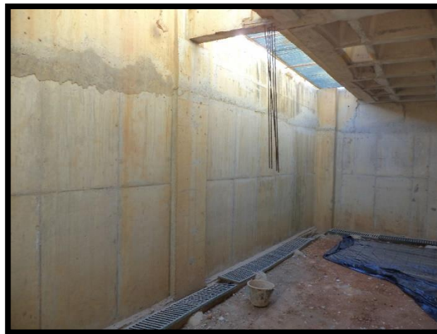
Figura 8 - Foto da cortina de contenção
