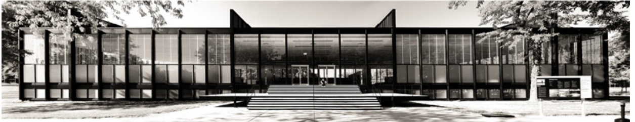
Figura 16 - Crown Hall, Chicago (fachada norte)
