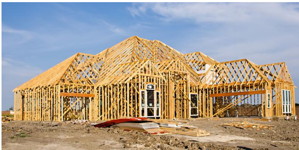
Figura 3.10 – Construção em wood frame
