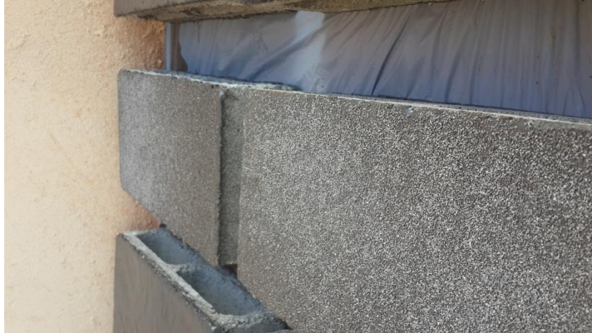
Figura 9 - Resultado final após aspersão do pó de brita
