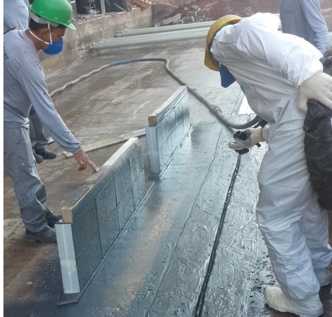
Figura 7 - Aplicação da poliuréia sobre os blocos de concreto.
