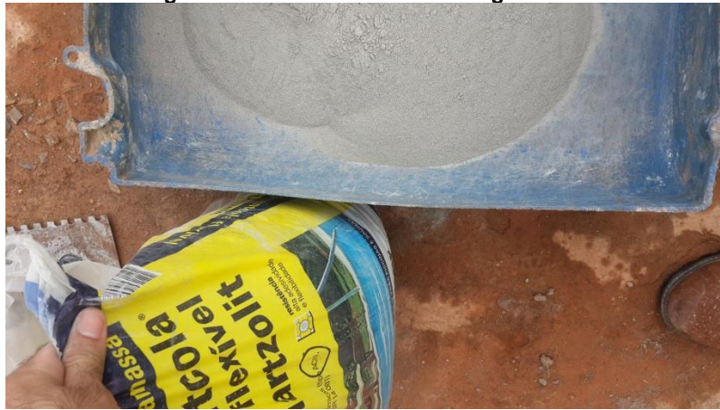
Figura 10 - Local da mistura da argamassa.
